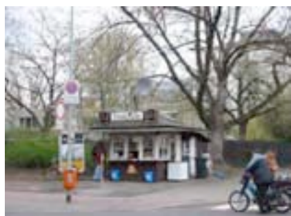
Bestehende Trinkhalle an der Quäkerwiese
