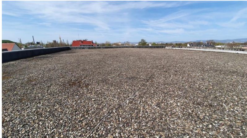
Abb. 6: Bei einzelnen Gebäuden (hier an der Ecke Elektronstraße – Akazienstraße) war auf die Bitumendecke Kies aufgebracht. Schon aufgrund der hohen Temperaturen und des bei Starkregen kurzzeitig anstehenden Wassers konnten Funktionen weitgehend ausgeschlossen werden.
