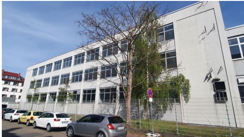
Abb. 4: An das Gebäude an der Ecke Elektronstraße – Akazienstraße lehnt sich eine Birke, die im Zuge des Abrisses entfernt werden muss.
