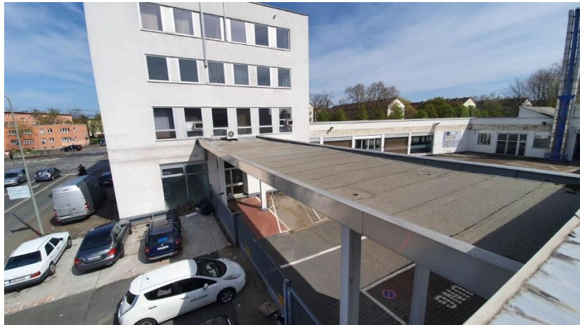
Abb. 1: Das Bürogebäude an der Ecke Mainzer Landstraße – Elektronstraße ist das höchste der abzureißenden Gebäude.
