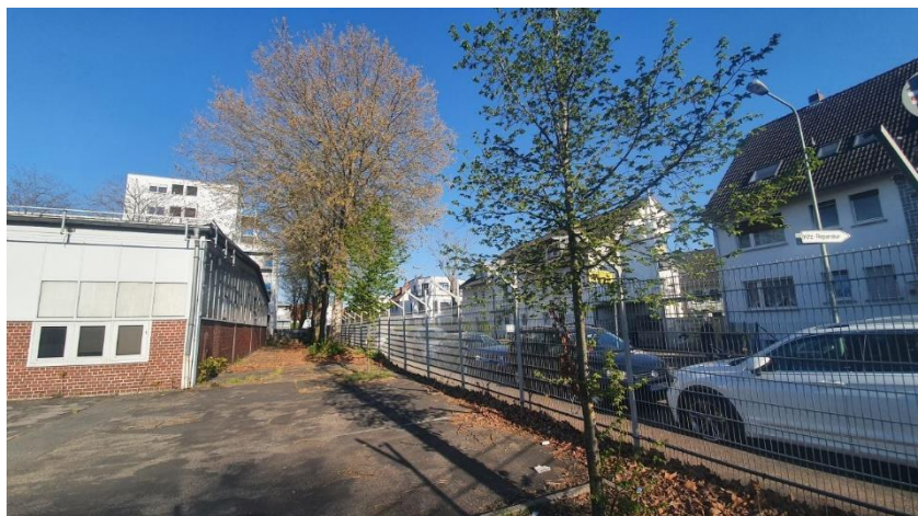
Abb. 3: Die Halle im Südosten des Areals ist auf zwei Seiten von Baumreihen umgeben. Um Schädigungen der Bäume zu vermeiden, bleibt hier das Fundament der Halle teilweise erhalten.
