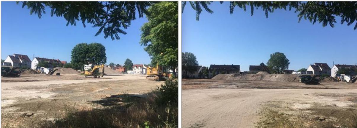
Abbildungen 8 und 9: Fotos zur Bestandssituation nach Abbruch: rechts Richtung Akazienstraße; links Richtung Elektronstraße
