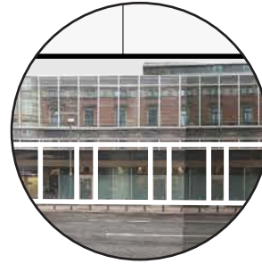
unattraktive Fassaden mit Servicezugängen
