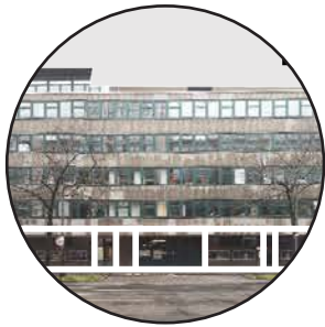
unattraktive Fassaden mit Servicezugängen
