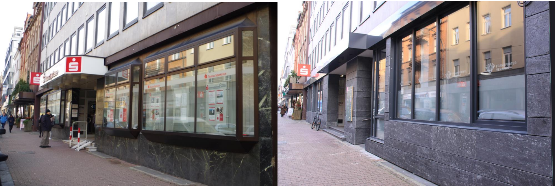
Fassade Zustand vor und nach Umbau
