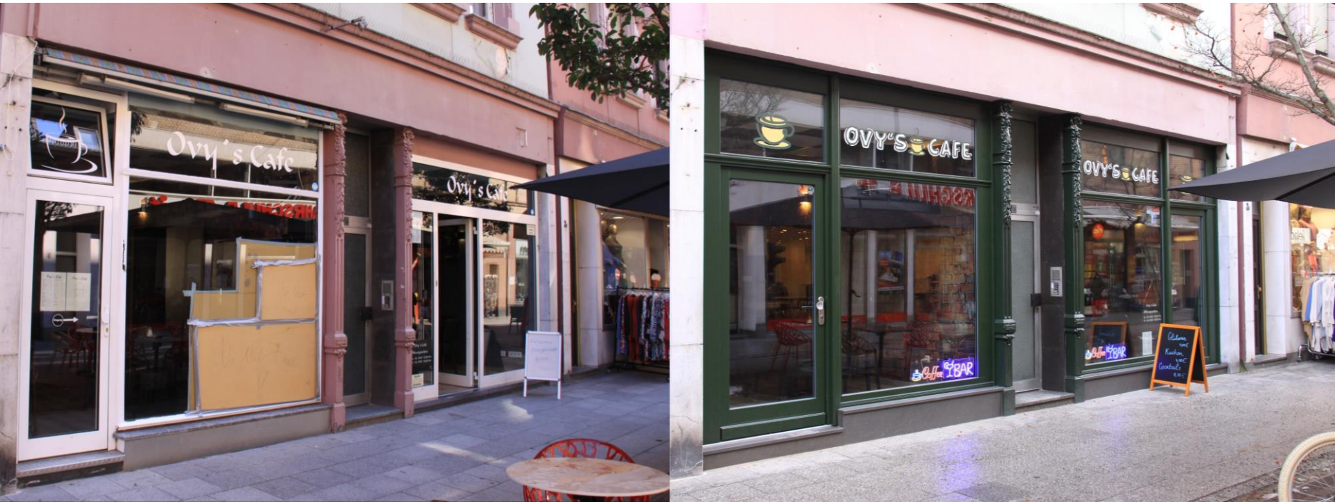
Fassade Zustand vor und nach Umbau
