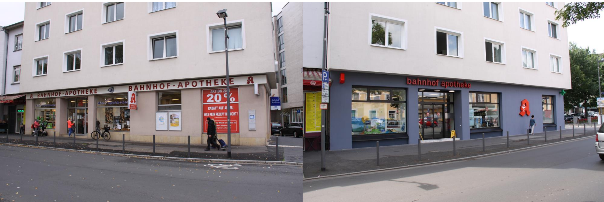
Fassade Zustand vor und nach Umbau
