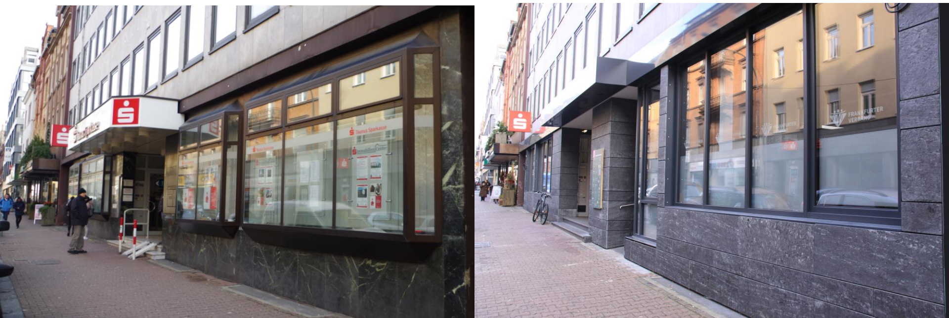
Fassade Zustand vor und nach Umbau
