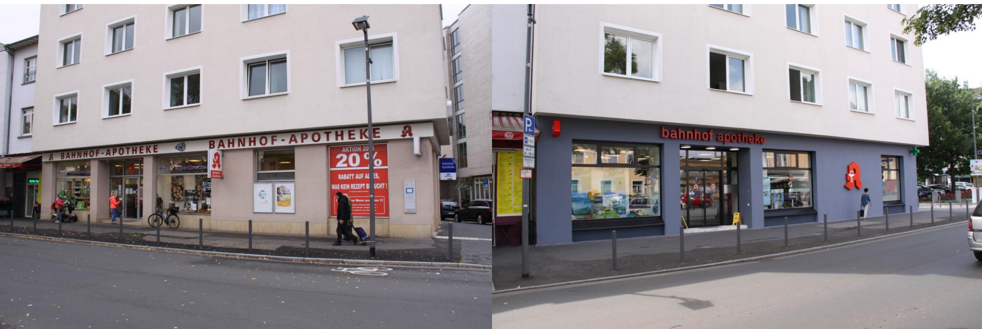
Fassade Zustand vor und nach Umbau
