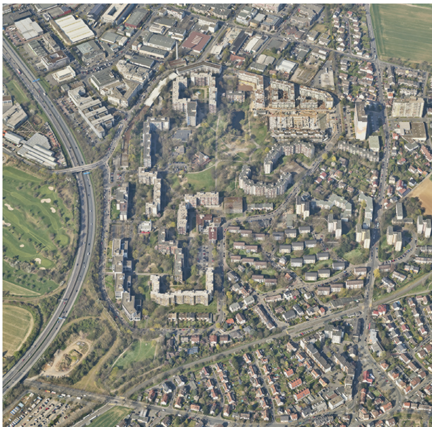
Schrägluftbild der Siedlung Ben-Gurion-Ring 2022 © Stadtvermessungsamt Frankfurt am Main
