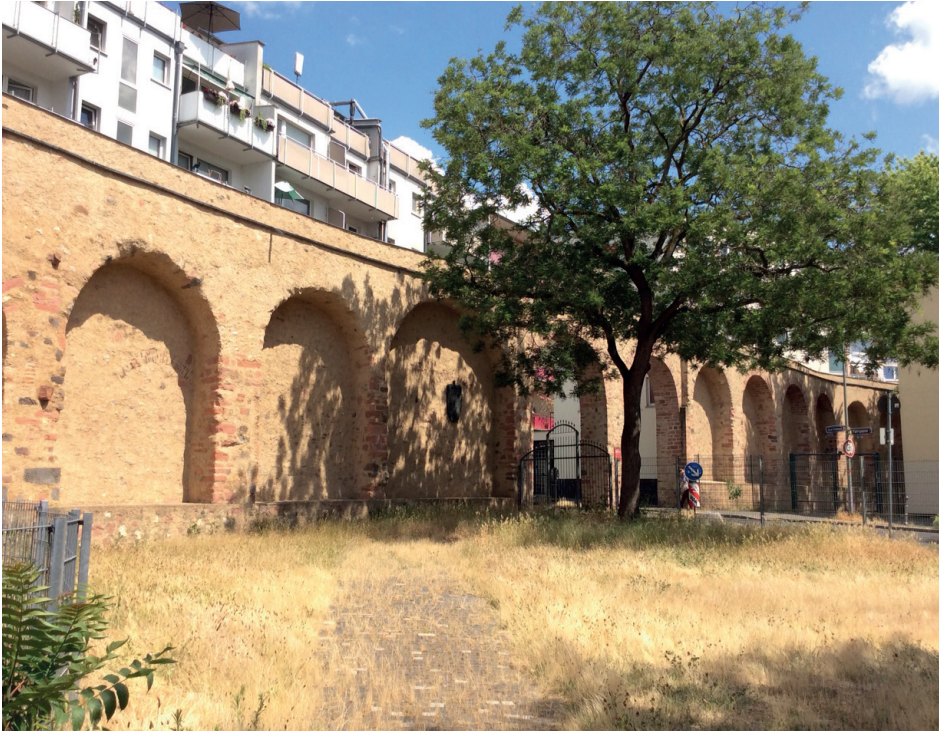
An der Staufenmauer
