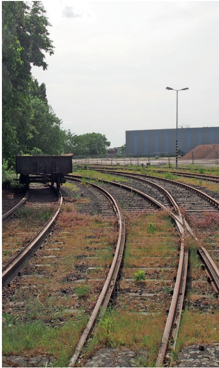
Noch vorhandene, aber nicht mehr genutzte Bahngleise im Industriegebiet
