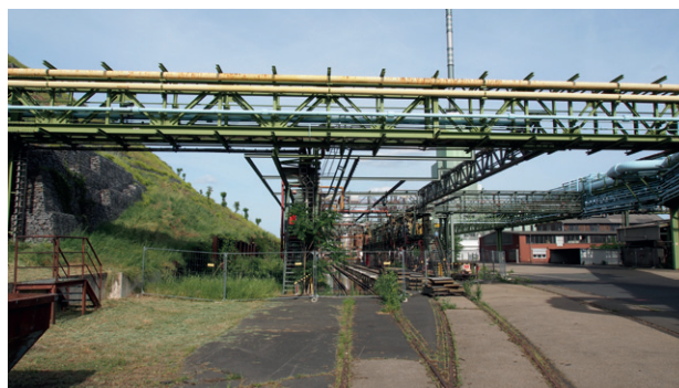
Rohrbrücken wie diese prägen den Bestand im Gebiet
