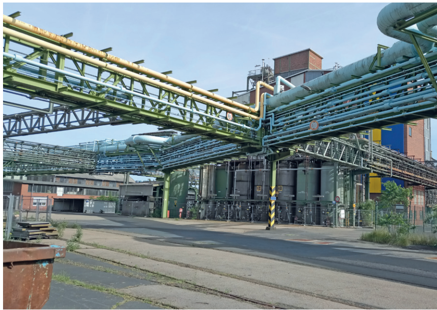
Rohrbrücken können attraktiv in die Gestaltung der Freiflächen integriert werden
