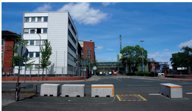
Blick von der Stroofstraße auf den Bestand am aktuellen Haupteingang
