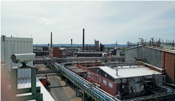
Blick vom Industriepark in Richtung Westen (Höchst)
