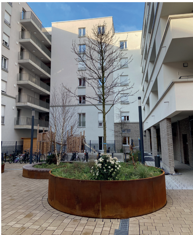
Nördlicher Innenhof als Erschließungszone und öffentlicher Treffpunkt
