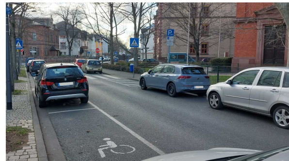
Melchiorstraße bei der Kirche (Fußgängerüberweg)
