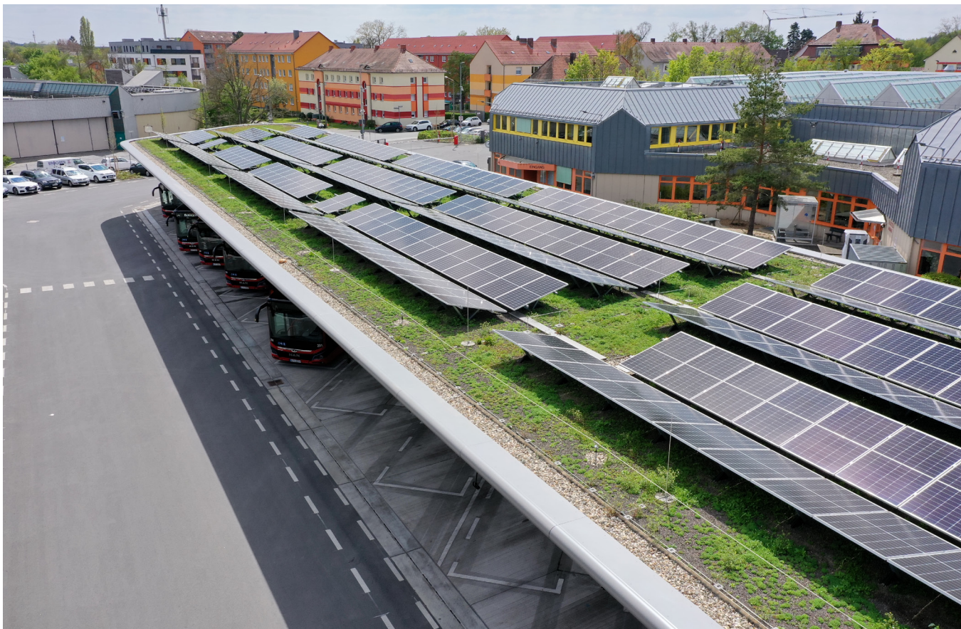
Überdachung Bushaltestelle © Bauder
