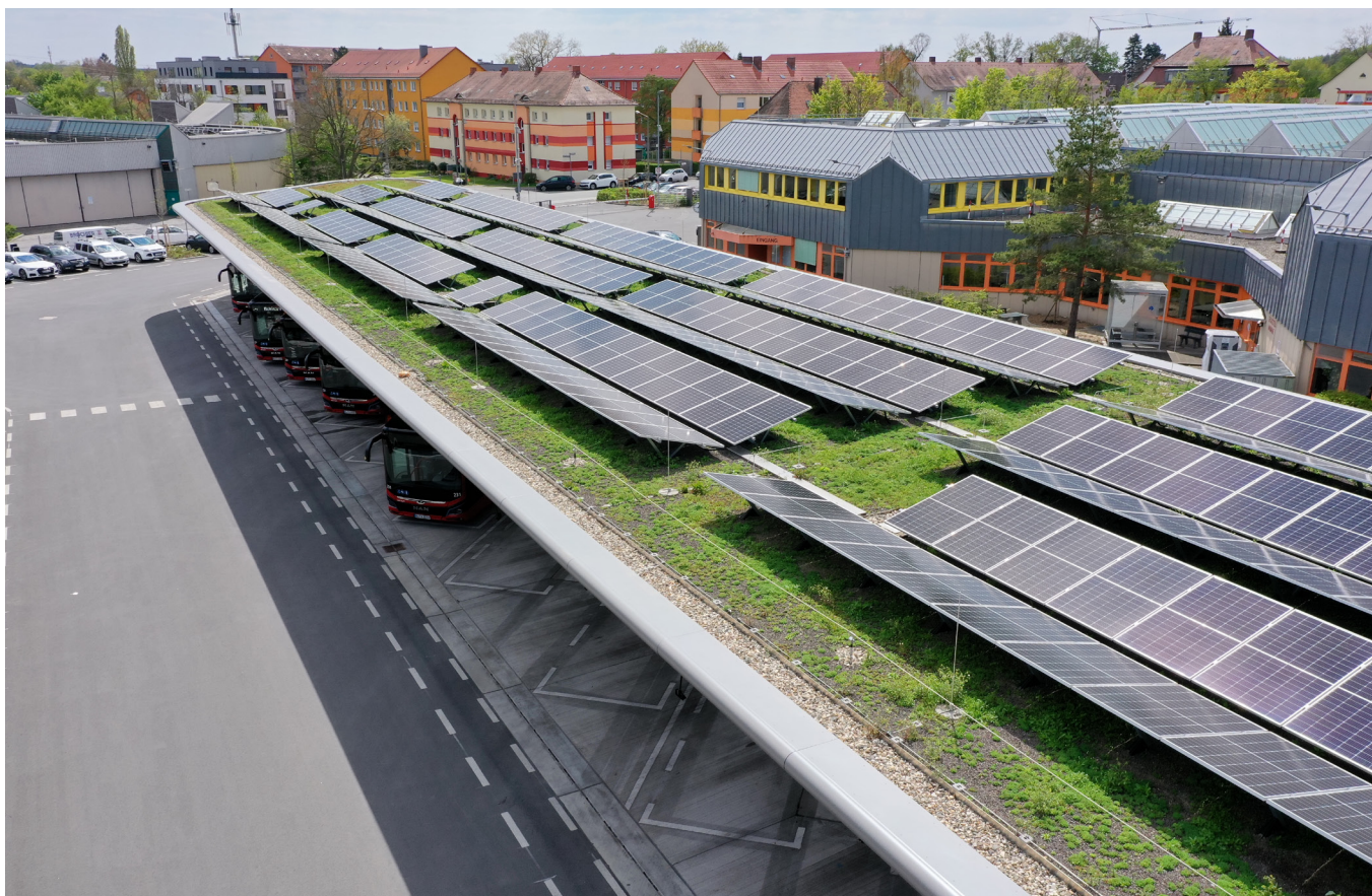
Überdachung Bushaltestelle © Bauder
