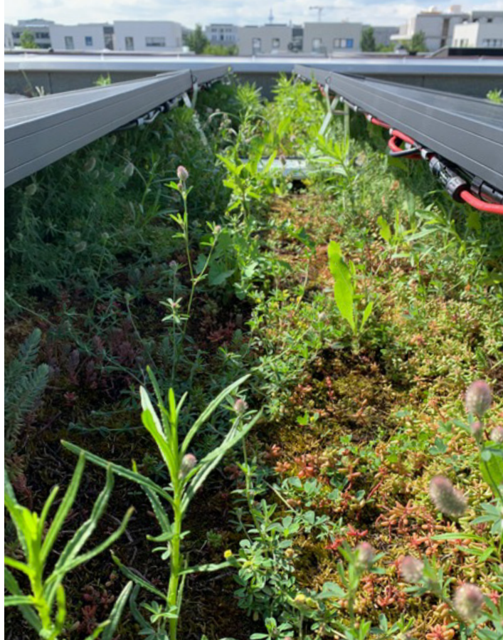
PV-Anlage bleibt unterhalb der Attika © Ina Mirel
