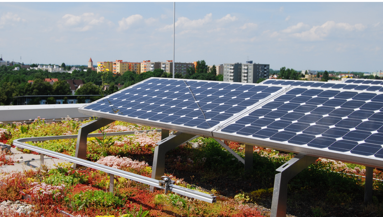
Dachbegrünung und Photovoltaik © ZinCo GmbH
