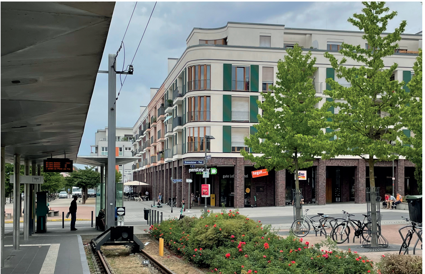
Tegut am Gravensteiner Platz: Orientierung des Eingangs auf den Fußgängerverkehr der Straßenbahn-Haltestelle und Bereitstellung von einfachen und überdachten Fahrradstellplätzen vor dem Eingangsbereich (Frankfurt am Main – Preungesheim, Gravensteiner Platz 4-6)
