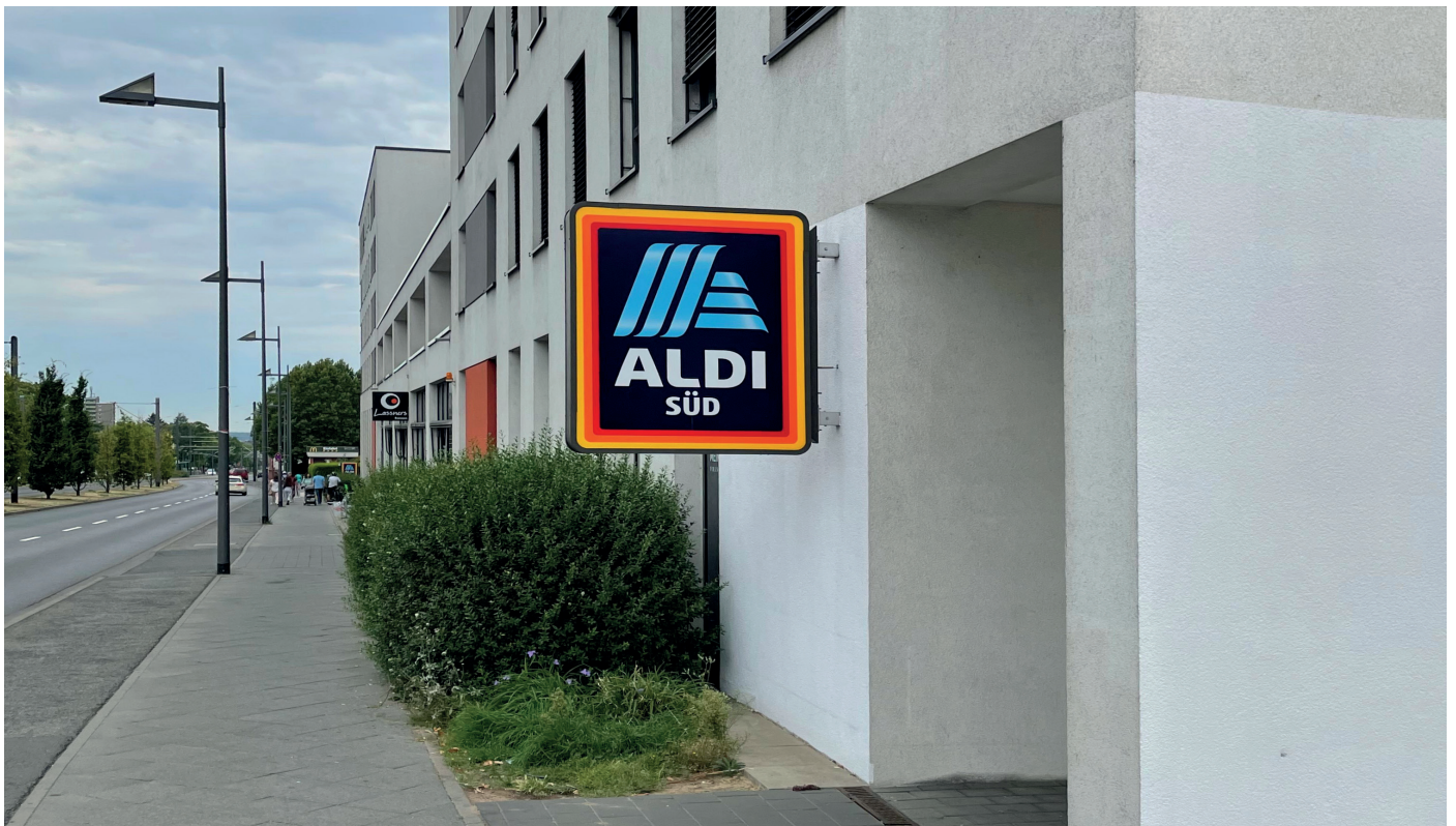
Angepasste Außenwerbung (Frankfurt am Main – Nordend-West, Friedberger Landstraße 295)
