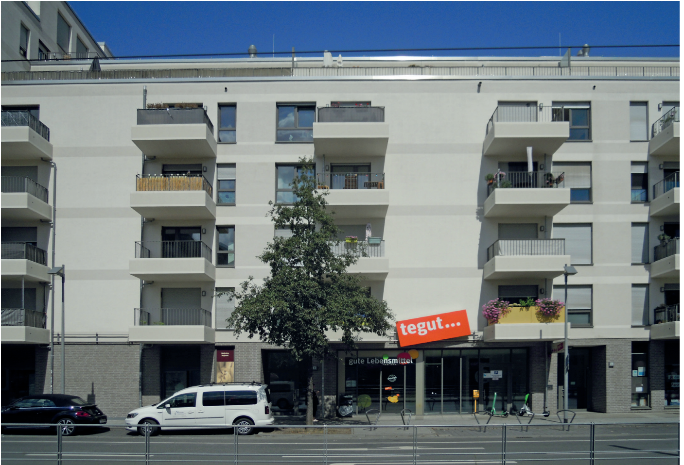
Supermarkt mit überbauten Wohnungen im Neubaugebiet (Frankfurt am Main – Bockenheim, Leonardo-da-Vinci-Allee 4-8)
