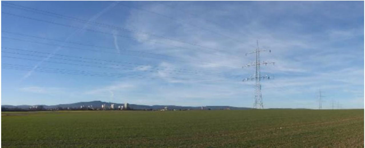
Abb. 6: 110-kV-Freileitung der Syna, die von Amprion mit zwei 380-kV-Systemen aufgerüstet werden soll
