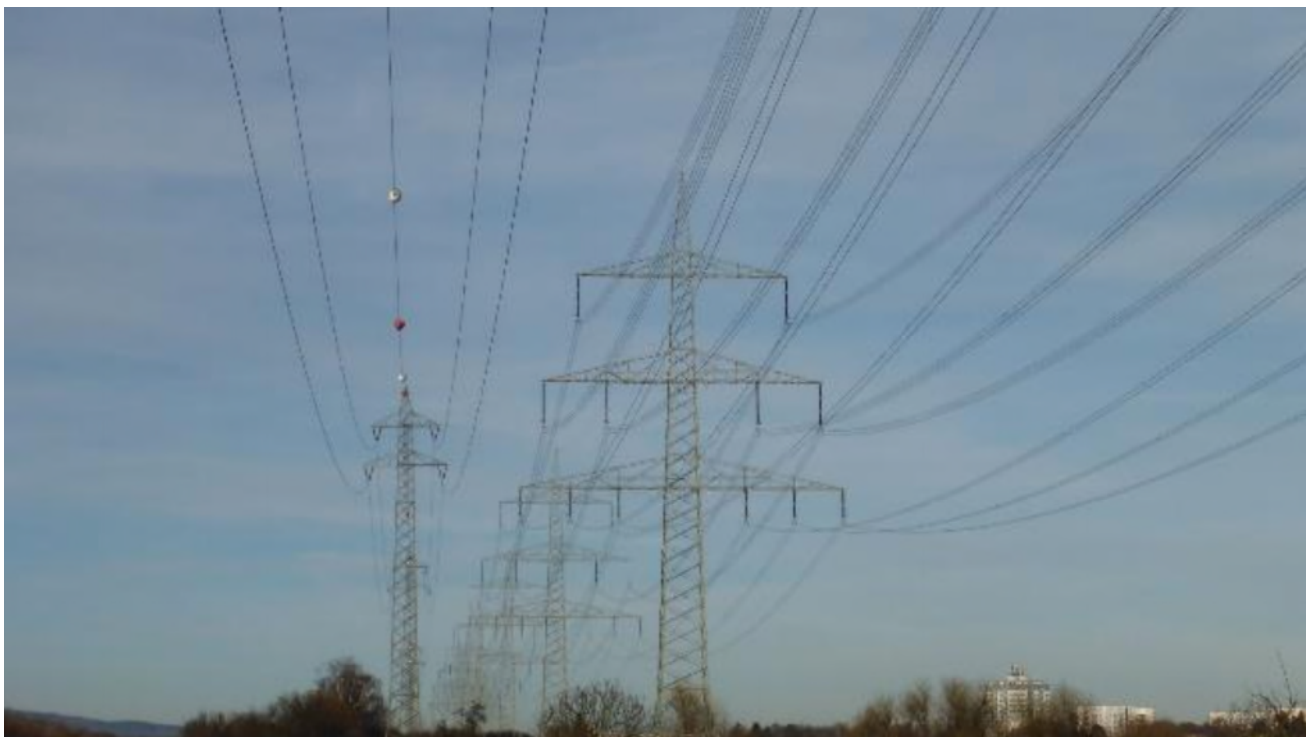
Abb. 5: DB Energie Trasse (links) und Avacon / TenneT-Trasse (rechts), Blick nach Norden.
