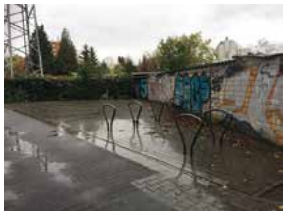
Abbildung 103: Kaum genutzte Fahrradabstellanlage südlicher Zuweg Bahn-Halt (Hessisches Landeskriminalamt 2019)
