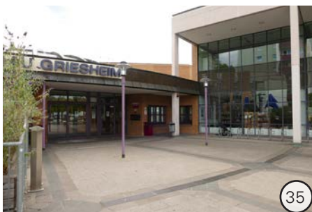
Eingangsbereich Saalbau Griesheim
