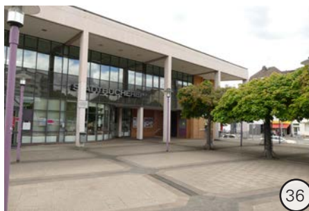
Eingangsbereich der Stadtbücherei
