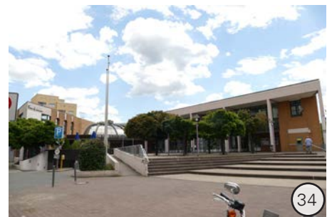
Eingangsbereich der Stadtbücherei
