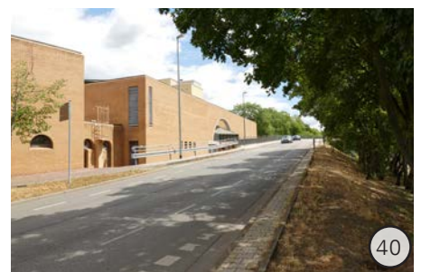
Stadtbücherei - entlang der Waldschulstraße
