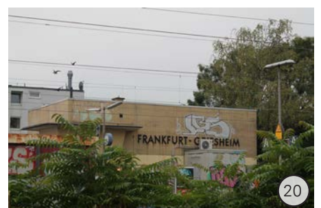
Stellwerk von Norden
