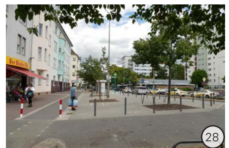
Zustand des Bürgersteigs
