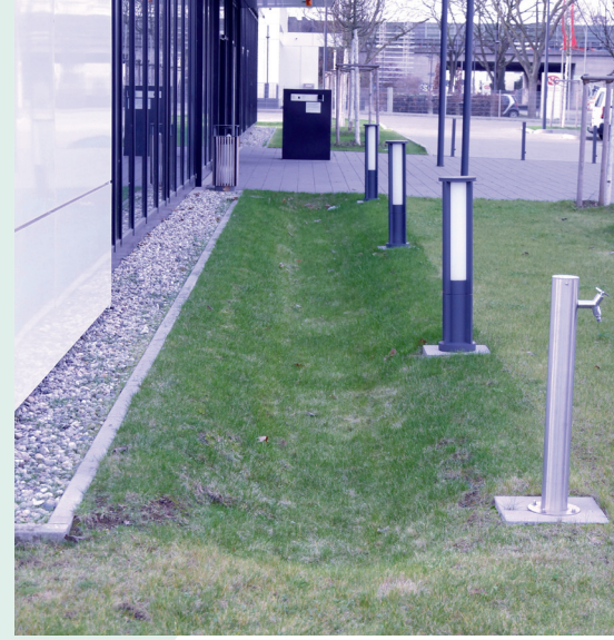
Muldenversickerung © Stadtentwässerung Frankfurt am Main
