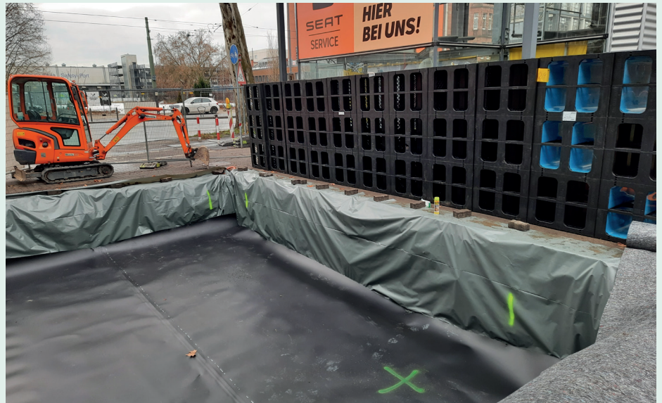
Rigole vor dem Einbau © Stadtentwässerung Frankfurt am Main
