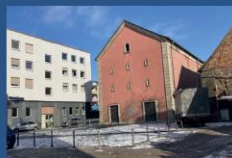
Ettinghausenplatz mit Luftschutzbunker nach den Grabungen 2021
