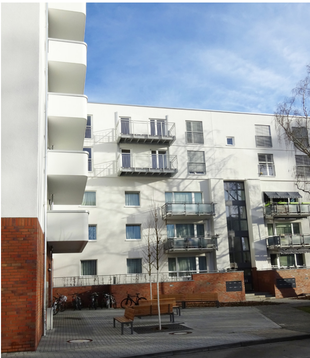
Aufstockung in Ginnheim
