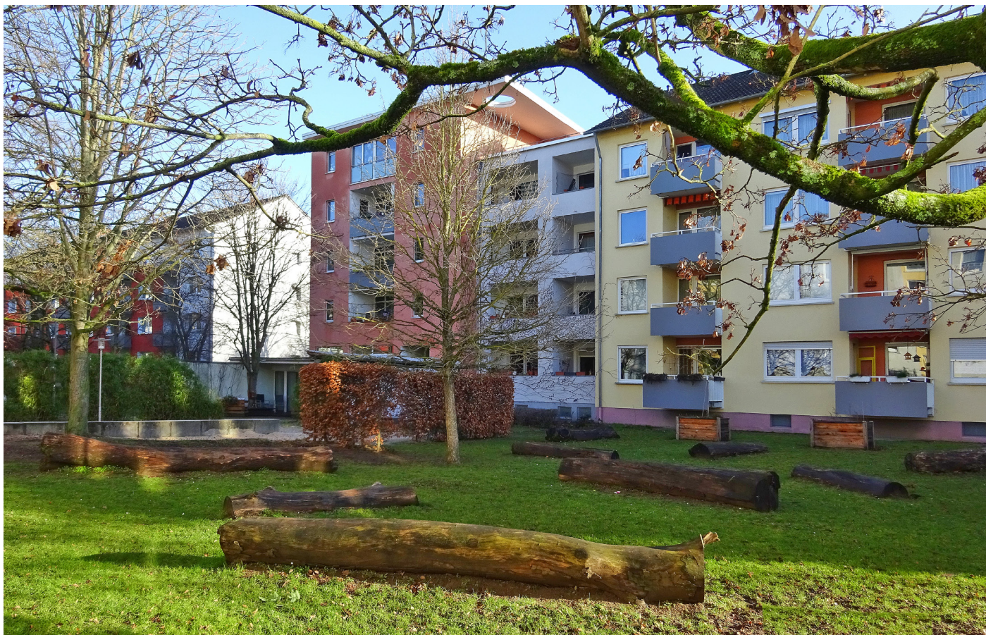
Freiflächengestaltung in Bergen-Enkheim
