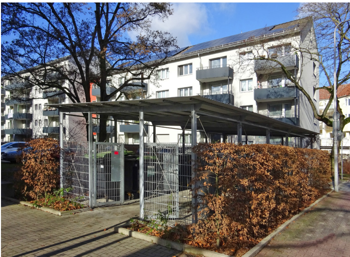
Baulich eingefasster und begrünter Müllstandort in Niederrad
