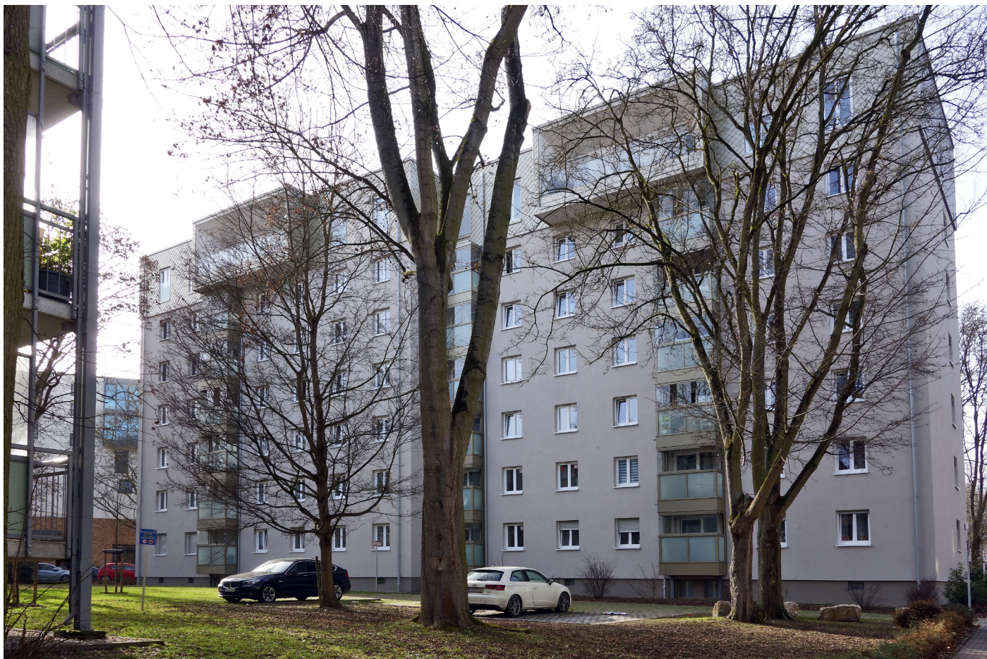
Aufstockung in Wiesbaden
