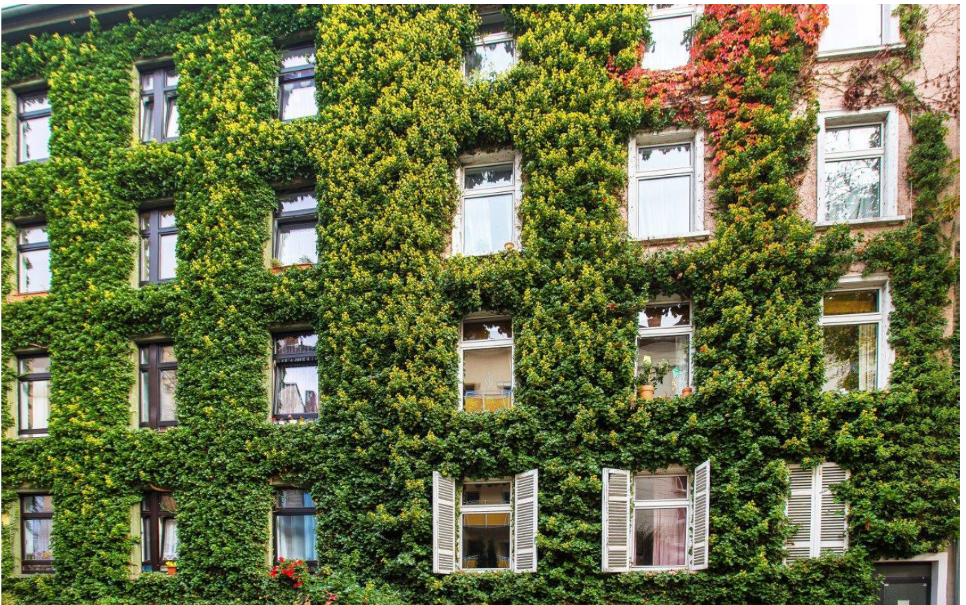
Fassadenbegrünung © E. Krumholz, Umweltamt Stadt Frankfurt am Main
