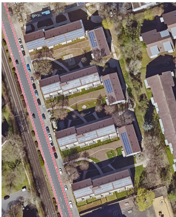
Solaranlagen in Eckenheim
