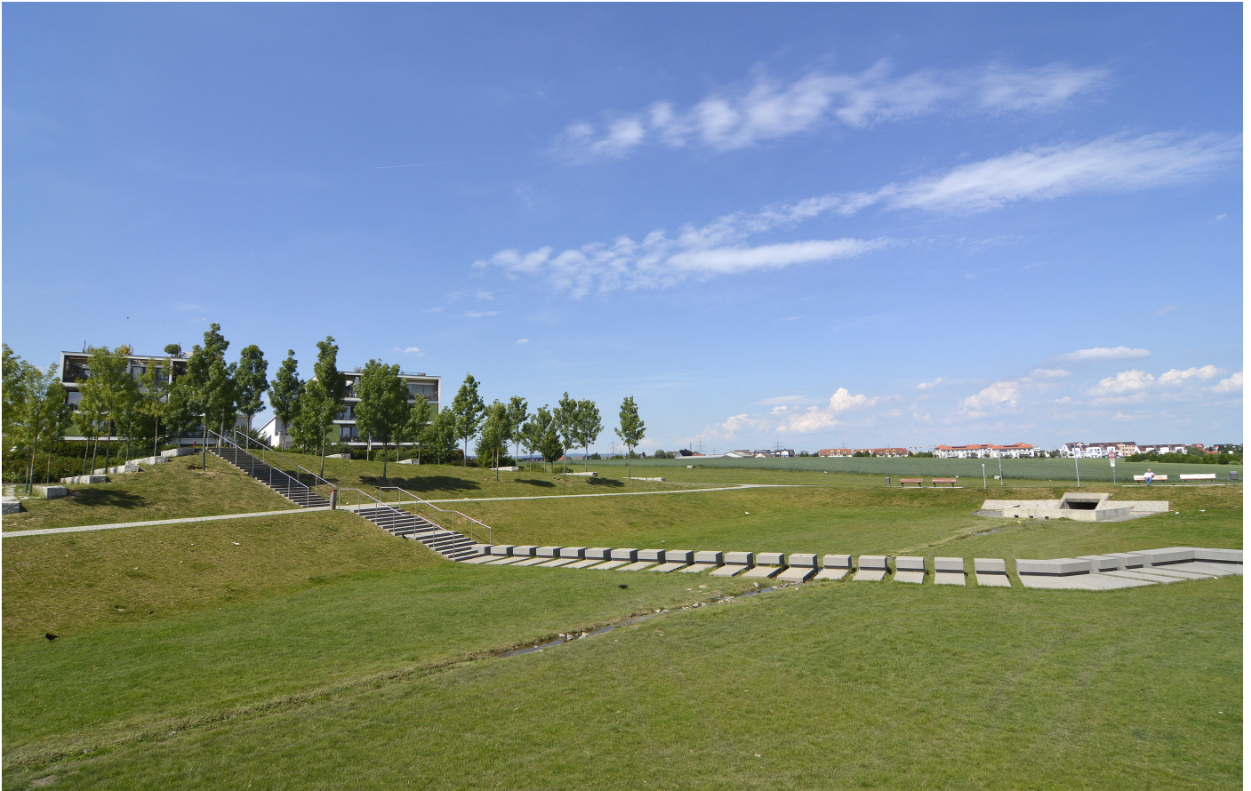
Retentionsfläche in Kalbach-Riedberg
