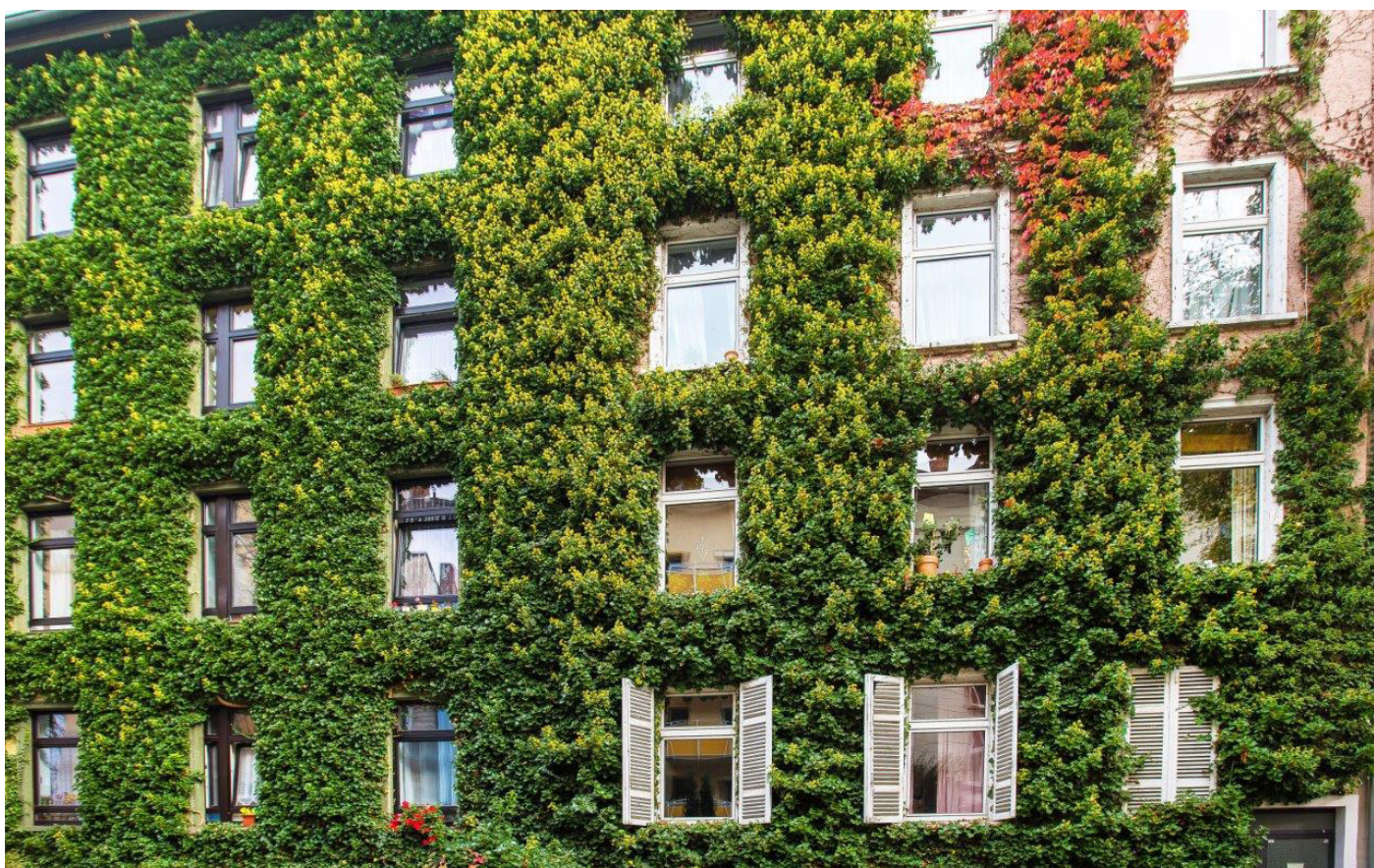
Fassadenbegrünung © E. Krumpholz, Umweltamt Stadt Frankfurt am Main
