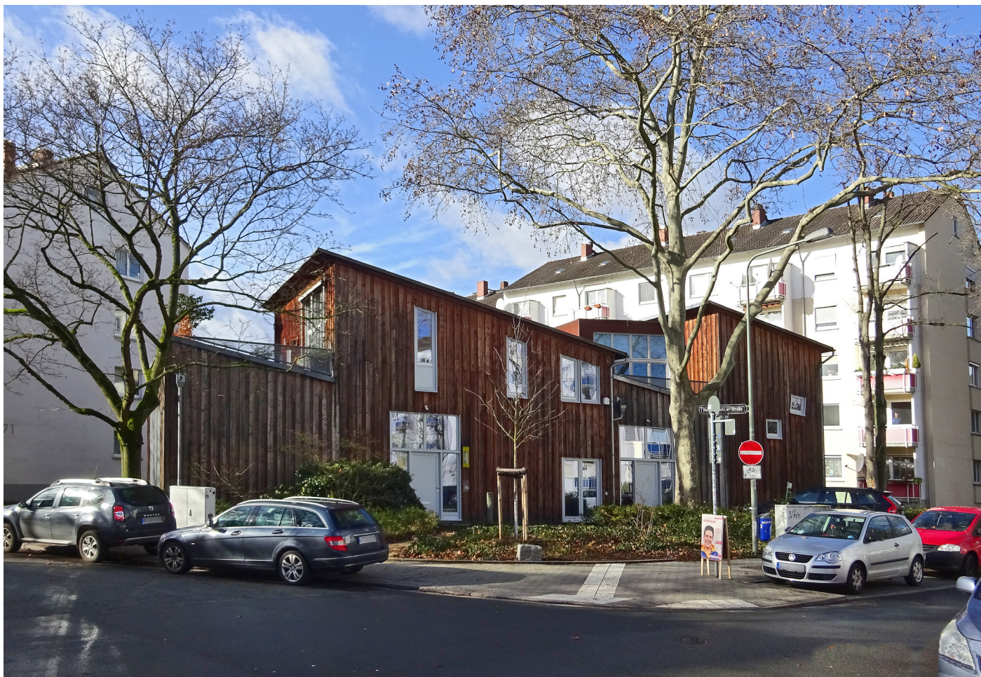
Ergänzungsbau in Holzbauweise in Niederrad
