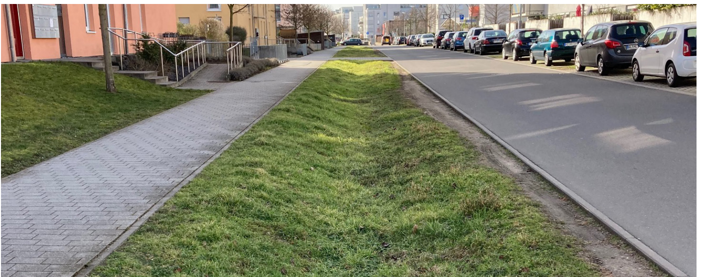
Straßenbegleitende Versickerungsmulde in Mainz
