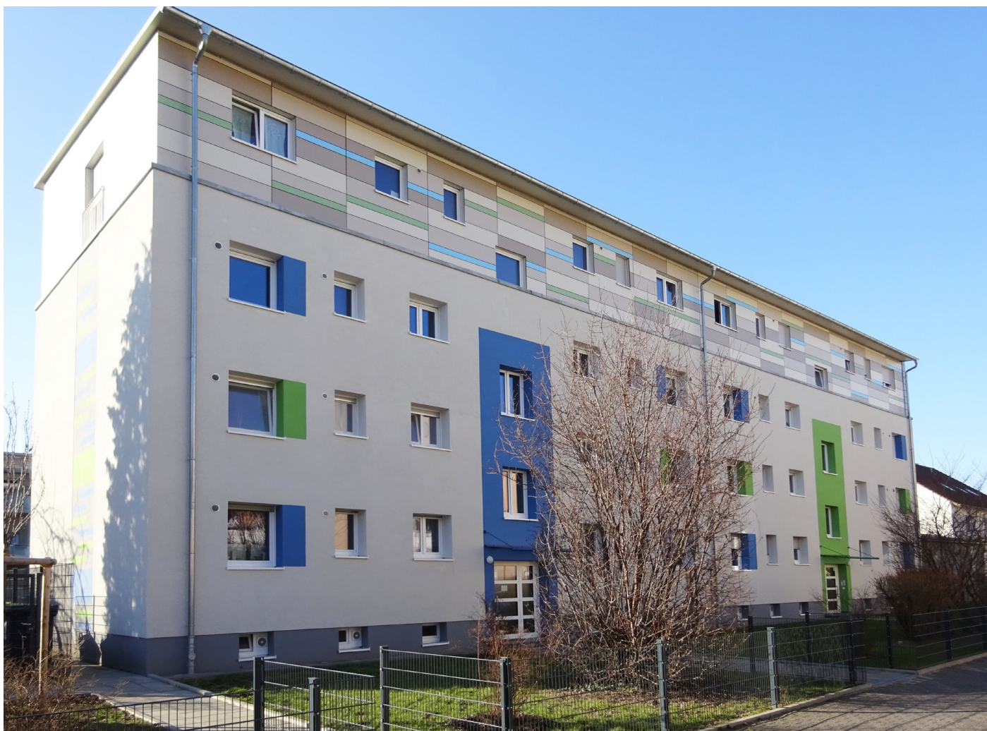
Aufstockung in Bockenheim
