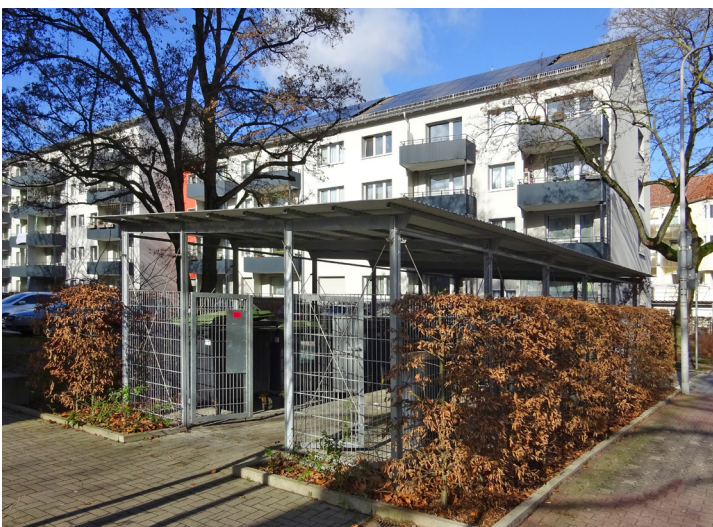
Baulich eingefasster und begrünter Müllstandort in Niederrad
