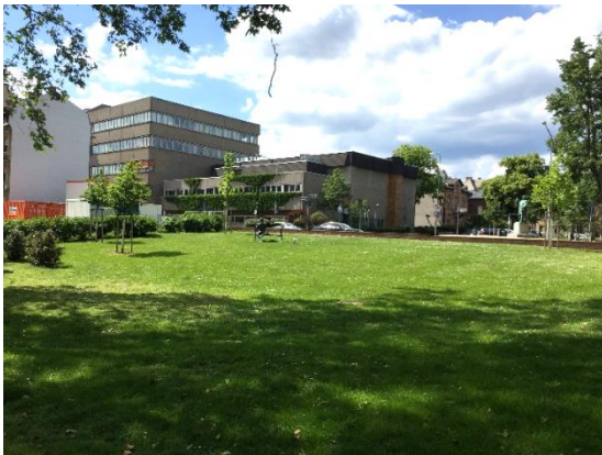
Abbildung 81: Grünflächenausbau nach Abriss des ehemaligen SÜWAG-Verwaltungsgebäudes (3)
