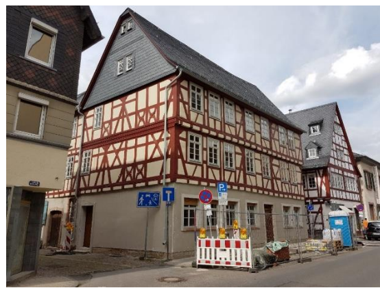
Abbildung 4: Geförderte Maßnahme erste Förderperiode (nach Modernisierung)
