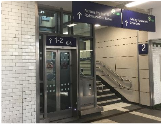
Abbildung 85: Neu gestaltete Bahnstufunterführung (7)
