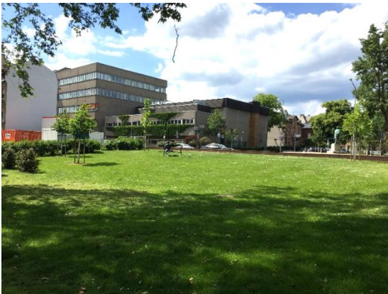
Abbildung 81: Grünflächenausbau nach Abriss des ehemaligen SÜWAG-Verwaltungsgebäudes (3)
