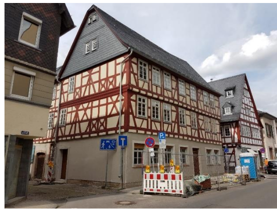
Abbildung 4: Geförderte Maßnahme erste Förderperiode (nach Modernisierung)
