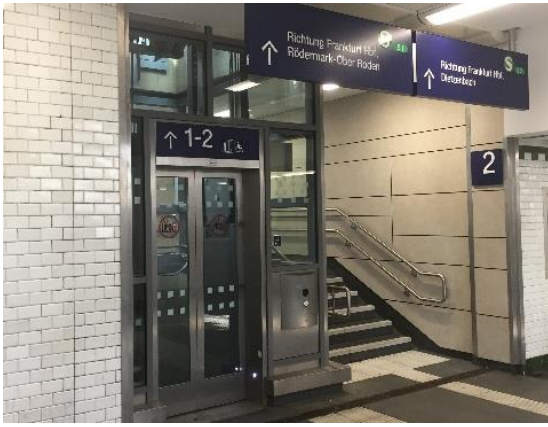
Abbildung 85: Neu gestaltete Bahnstufunterführung (7)
