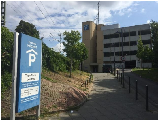
Abbildung 91: Das Parkhaus Höchst in der Billtalstraße (13)
