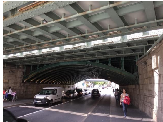
Abbildung 92: Ausbau der Beleuchtung in der Unterführung nördlich des Dalbergkreises (14)
