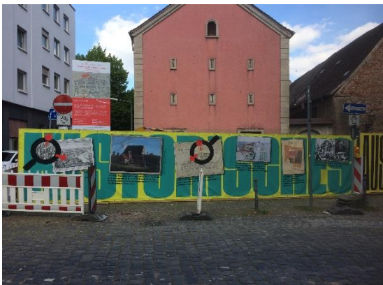
Abbildung 163: Bauzaungestaltung Grabungen Ettinghausenplatz Frühjahr 2020
