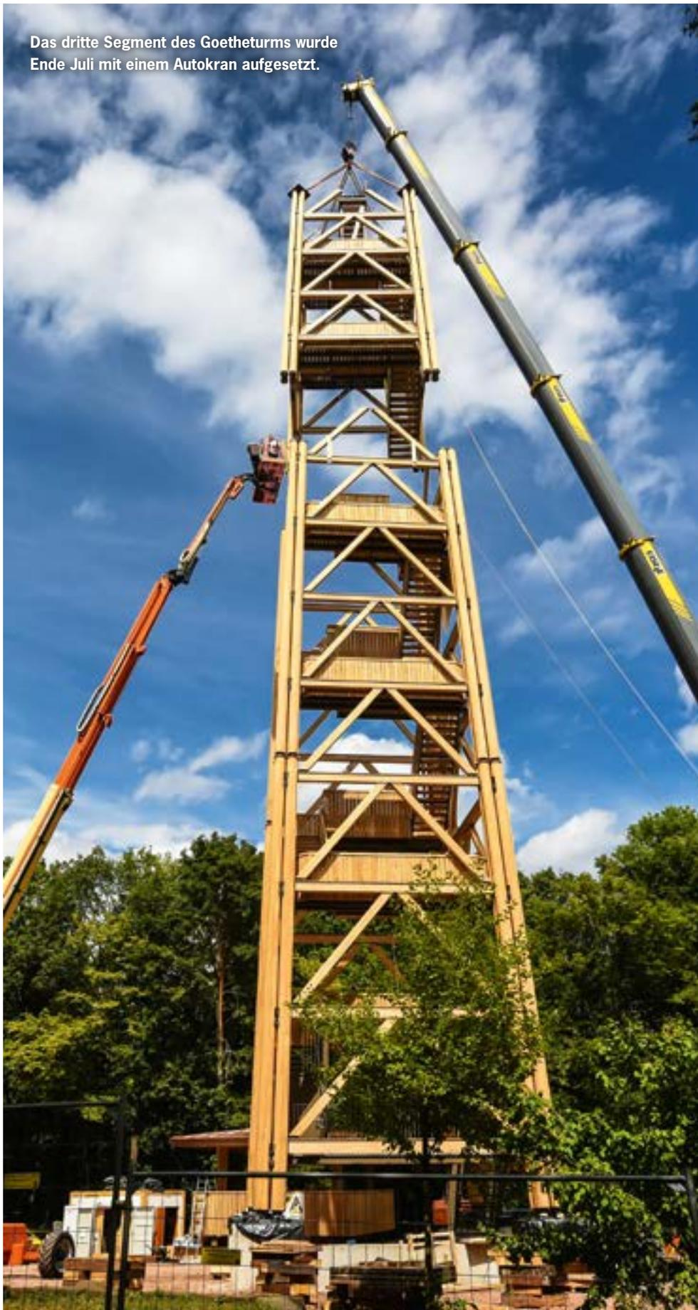
Der Goetheturm steht wieder: Ende Juli wurde das beliebte Wahrzeichen mit Hilfe eines großen Autokrans aus mehreren vormontierten Einzelteilen zusammengesetzt. Seitdem ragt der Aussichtsturm wieder über die Wipfel des Stadtwalds und ist schon von weitem sichtbar.
