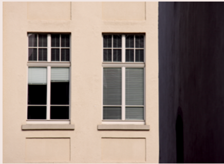
Regelmaterial Obergeschosse: Putz
