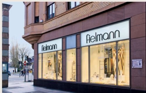
Beispiele von gut in die Gesamtfassade integrierten Erdgeschossfassaden
