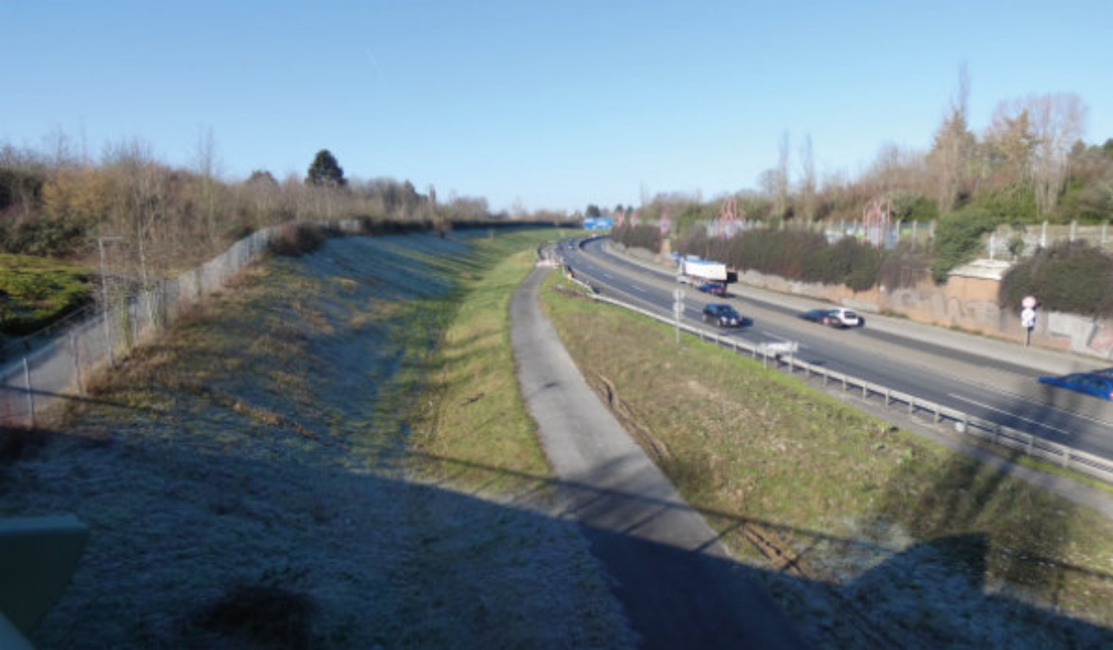
Blick von der Brücke Seckbacher Landstraße in den Untersuchungsraum, © DEGES
