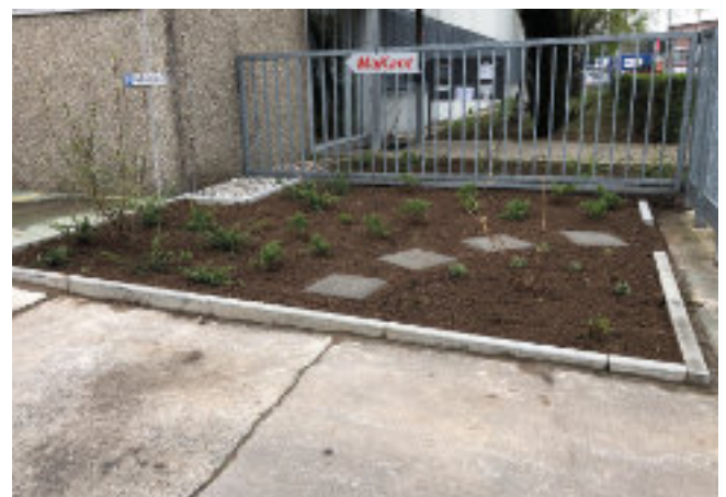
Entsiegelung und Begrünung von Stellplätzen
