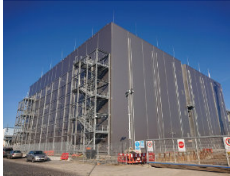
Neues Rechenzentrum an der Friesstraße
