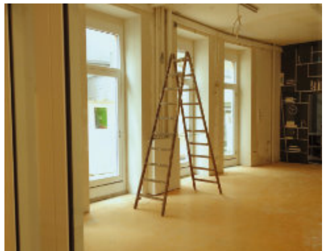
Gutleutstraße 8-12, Erdgeschosszone, nach dem Umbau © BSMF
