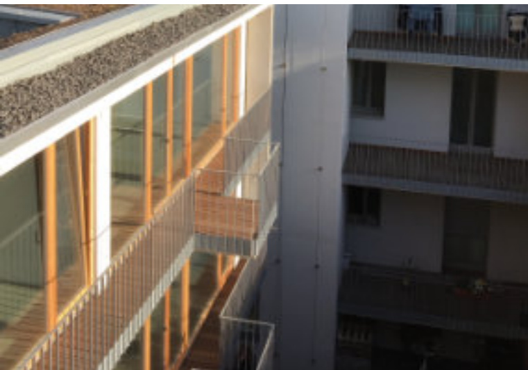
Beispiel für eine Revitalisierung im Bereich hinter der Straße „Schöne Aussicht“
