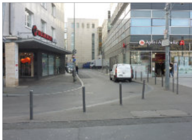
Bestandsituation vor dem Umbau
