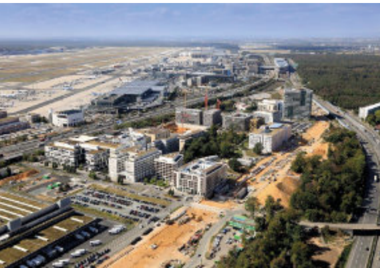
Der neue Stadtteil am Flughafen wächst © FRAPORT AG
