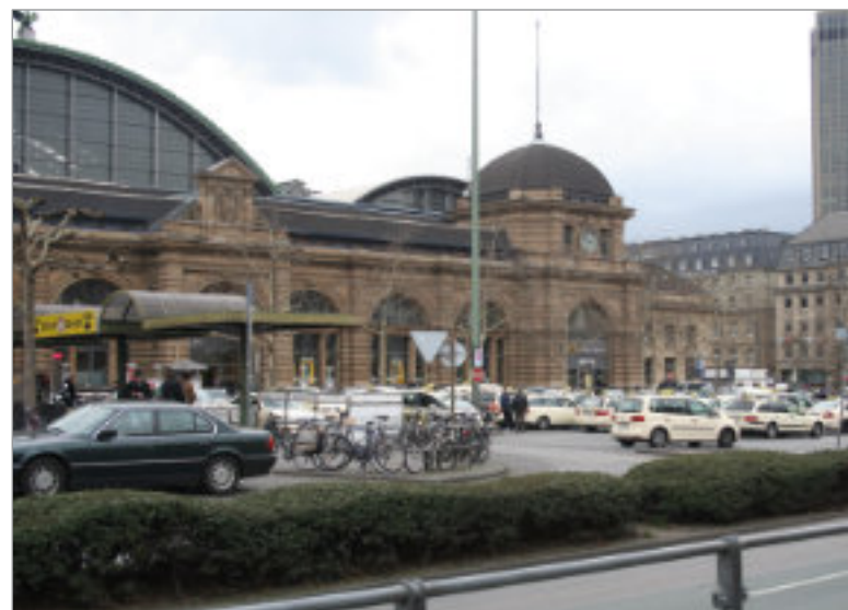
Funktionalität und Gestaltung der Vorplätze werden der Bedeutung des Hauptbahnhofs als Tor zur Stadt nicht mehr gerecht
