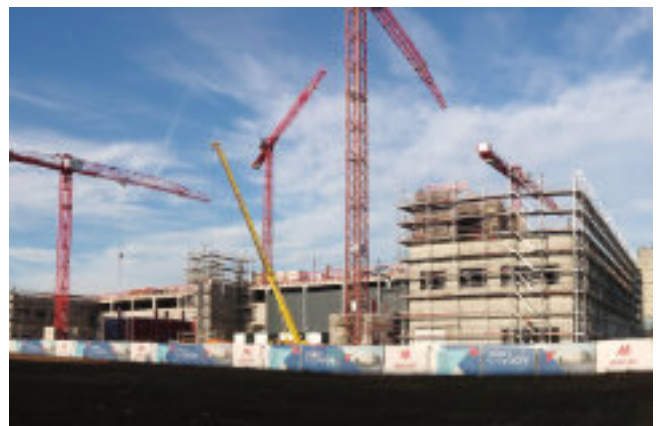
Rechenzentrum im Bau an der Wilhelm-Fay-Straße
