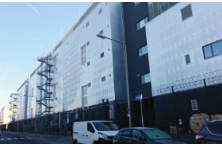
Rechenzentren in der Weismüllerstraße
