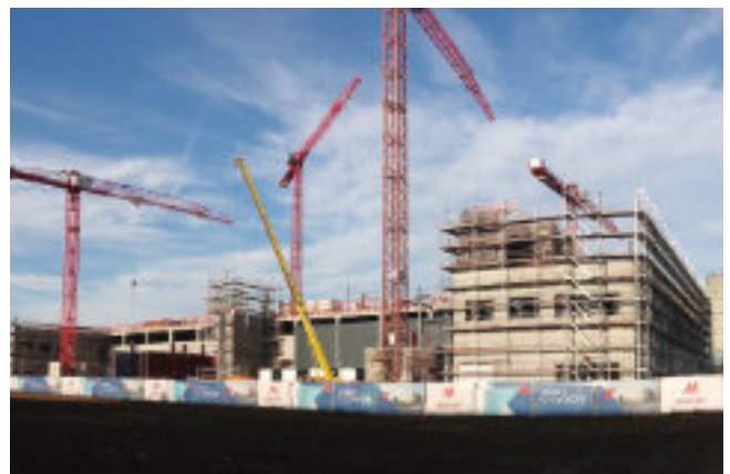
Rechenzentrum im Bau an der Wilhelm-Fay-Straße
