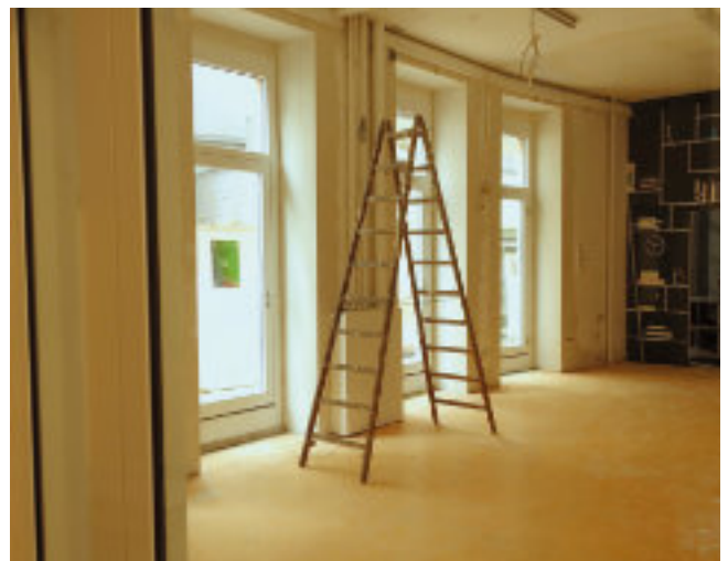
Gutleutstraße 8-12, Erdgeschosszone, nach dem Umbau © BSMF
