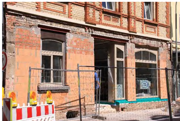
Baustelle Ende Juni 2020
