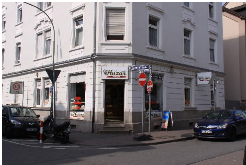
Bestand vor Sanierung
