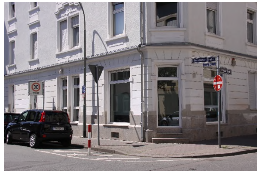
Fassade kurz vor Fertigstellung
