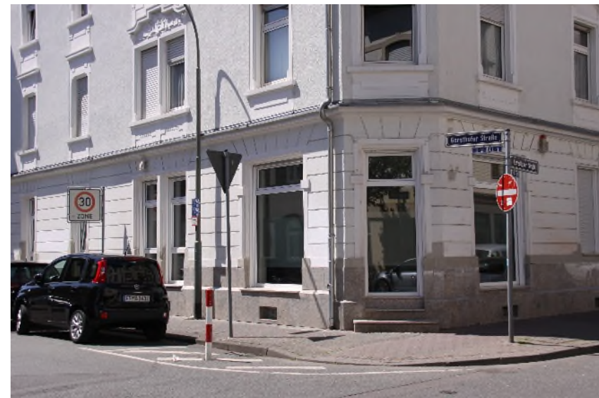
Fassade kurz vor Fertigstellung
