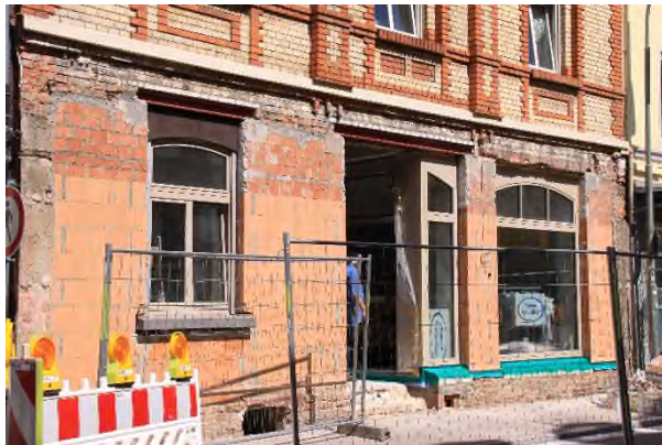
Baustelle Ende Juni 2020
