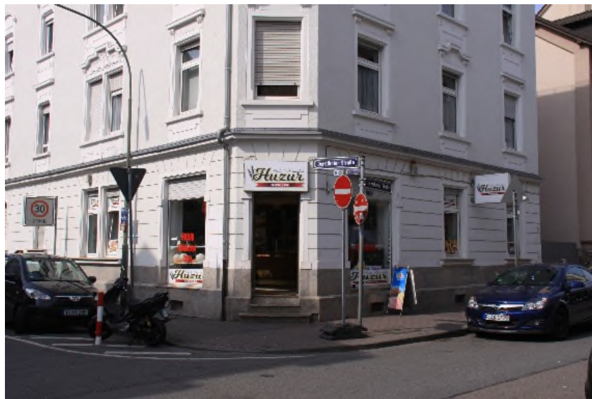
Bestand vor Sanierung
