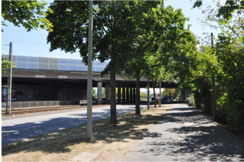
Mainzer Landstraße / Bundesautobahn A 5
