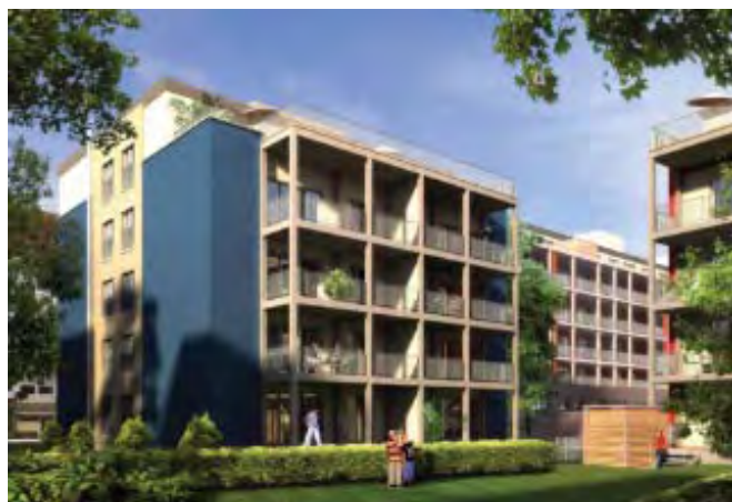
Mehrfamilien-Passivhaus Sophienhof, Bockenheim
