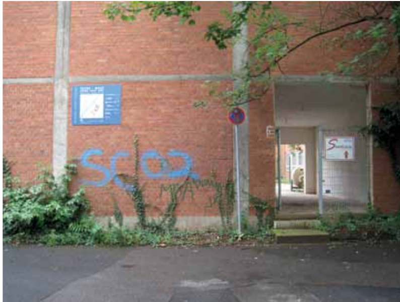
Kleines Hinweisschild Teves West am Eingang Ehinger Straße
