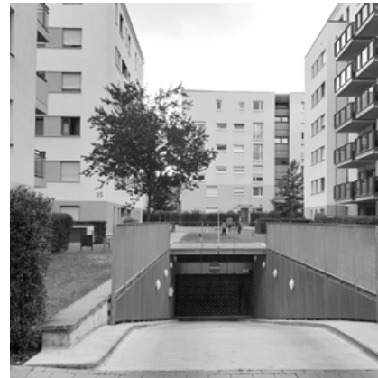
Freiliegende Tiefgaragenrampen im Außenbereich sollten vermieden werden.
