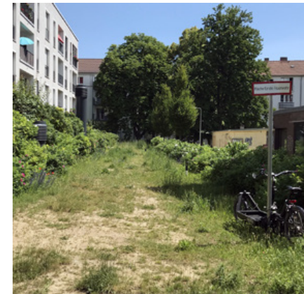
Rückseitige Feuerwehruzufahrt (mit Schotterrasen) in Bornheim.
