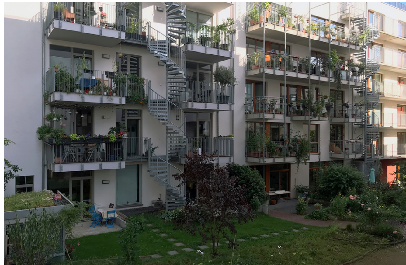
Gartenseitige Fluchttreppe als zweiter Rettungsweg (Naxos-Areal).
