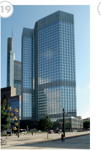
Bankgebäude „Eurotower“ Willy-Brandt-Platz 2
