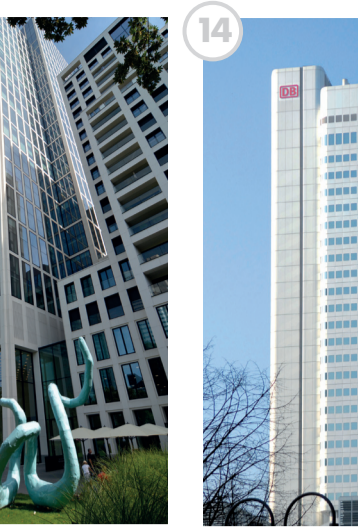
Büro-/Geschäftsgebäude „Silver-Tower“ Jürgen-Ponto-Platz 1
