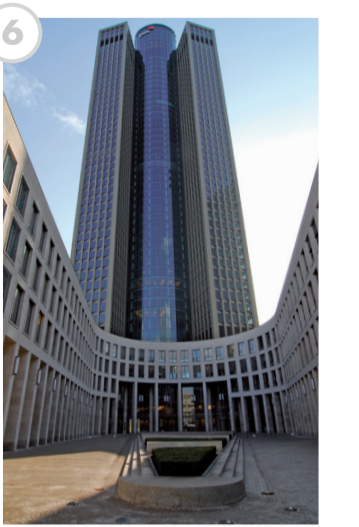
Bürogebäude „Tower 185“ Friedrich-Ebert-Anlage 35/37
