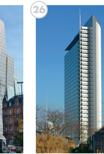
Büroturm „Pollux“ Platz der Einheit 2
