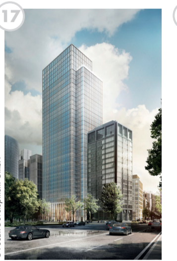
Büroturm „Marienturm“ Tausunanlage 9-10
