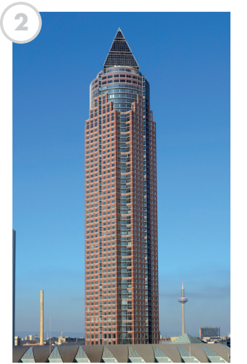
Bürohaus Messeturm Ludwig-Erhard-Anlage 1
