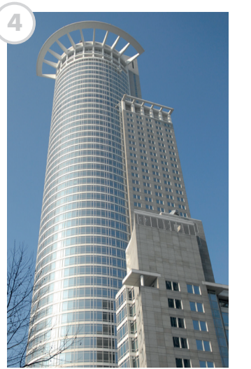
Bürohaus „Westend-Tower“ Mainzer Landstraße 58
