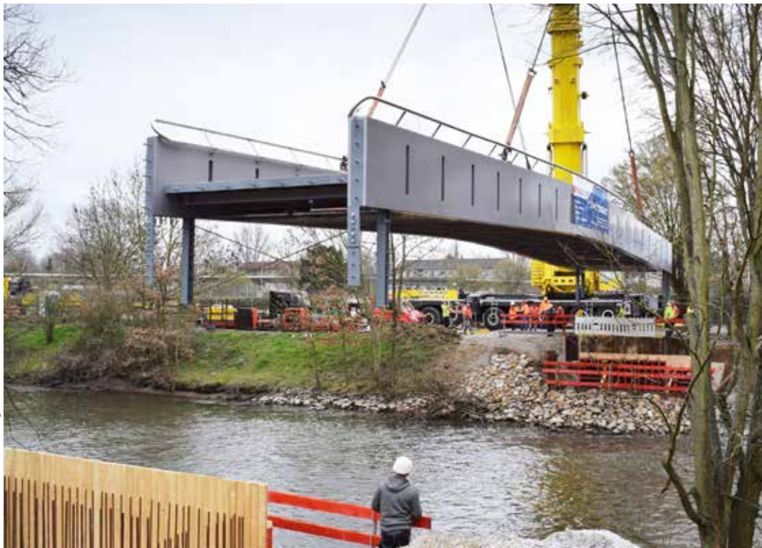
Ein mobiler Schwerlastkran setzt die neue Brücke aus Stahl behutsam auf die Fundamente.
