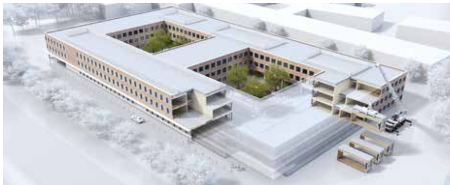
Das Gebäude für Gymnasium und Grundschule wird aus 350 Holzmodulen zusammengesetzt.
