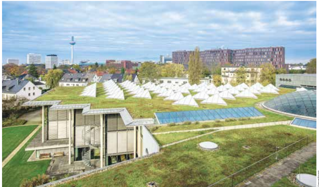
Das extensiv begrünte Dach der Deutschen Nationalbibliothek.
