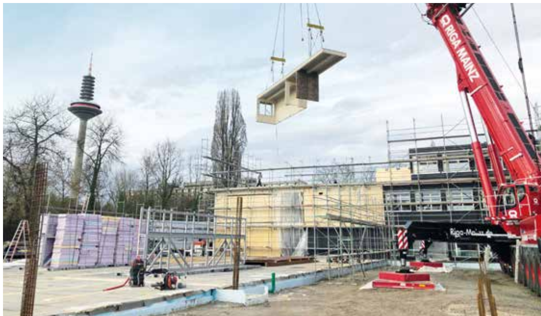
In Frankfurt werden die Module auf dem Tieflader angeliefert und mit dem Kran eingehoben.
