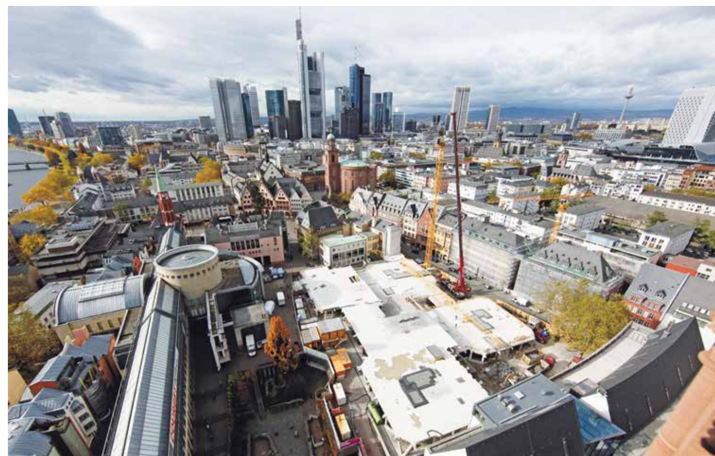
Die Baustelle in ihren Anfangsjahren.
