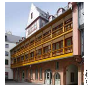
Historische Fassade des Rebstockhofes.
