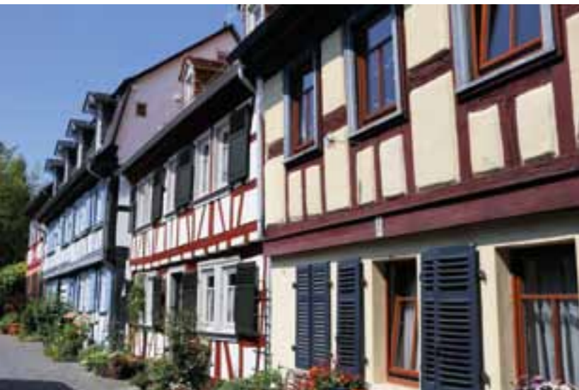
Sanierte Fachwerkgebäude in der Höchster Innenstadt © NH ProjektStadt
