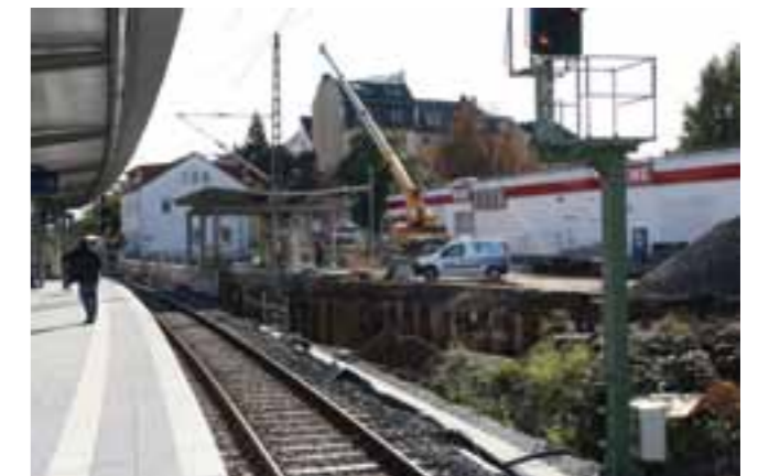
Neubau der S-Bahnhaltstelle Rödelheim mit Ausgang Westseite, 2011
