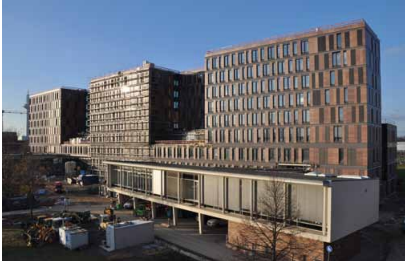
Ansicht der Frankfurt School von Südosten 1/2017 Entwurf Henning Larsen Architects/ Ausführung MOW Generalplanung GmbH © Frankfurt School of Finance & Management
