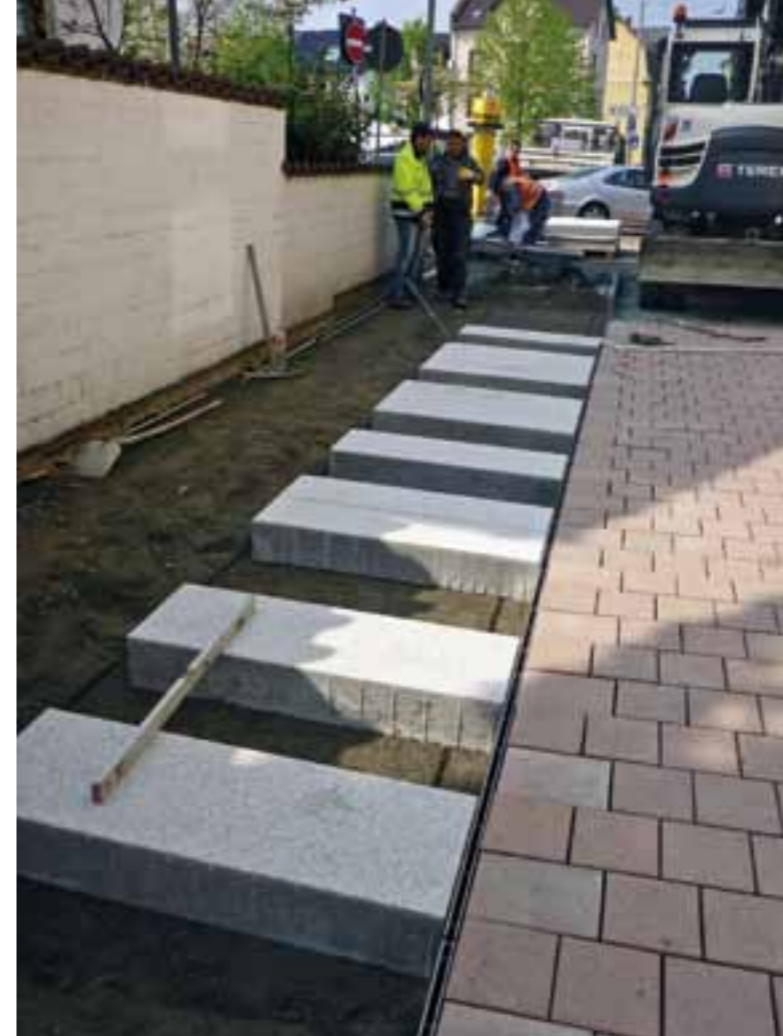
Verlegung der Magnumplatten in der Lappengasse
