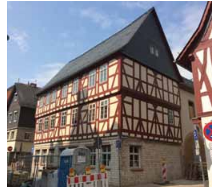
Bolongarostraße 156 während der Sanierung © NH ProjektStadt
