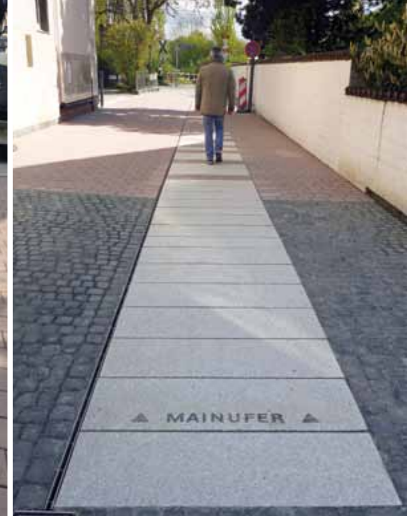
Richtungsweisender Plattenstreifen mit Hinweisgravur
