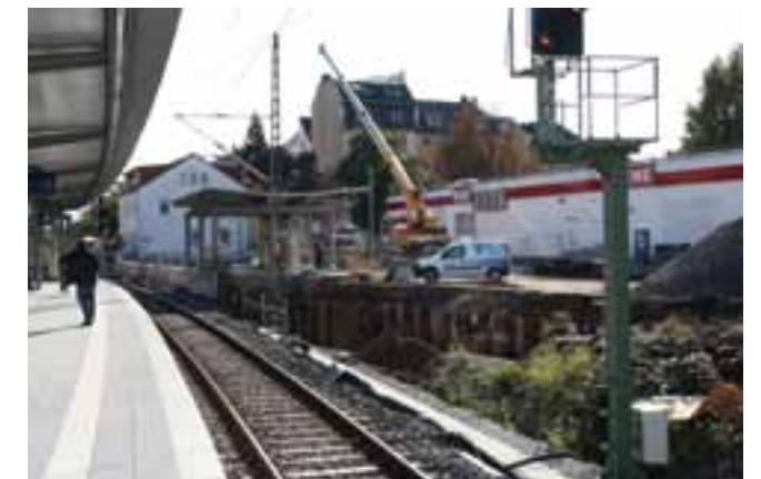
Neubau der S-Bahnhaltestelle Rödelheim mit Ausgang Westseite, 2011
