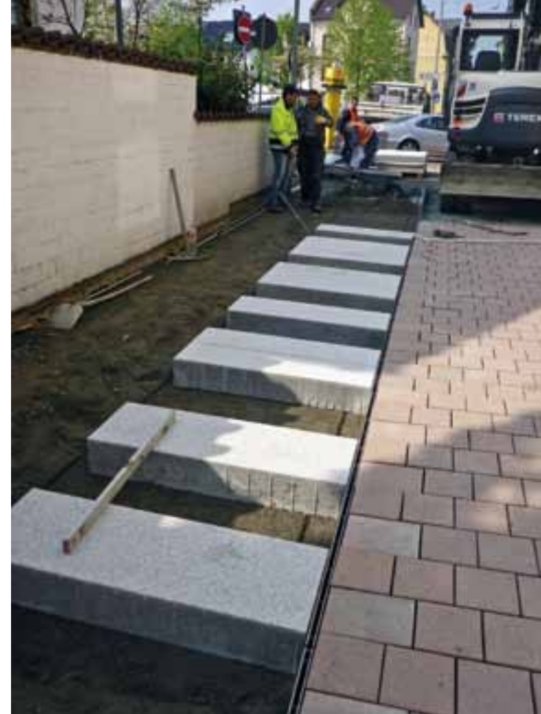
Verlegung der Magnumplatten in der Lappengasse
