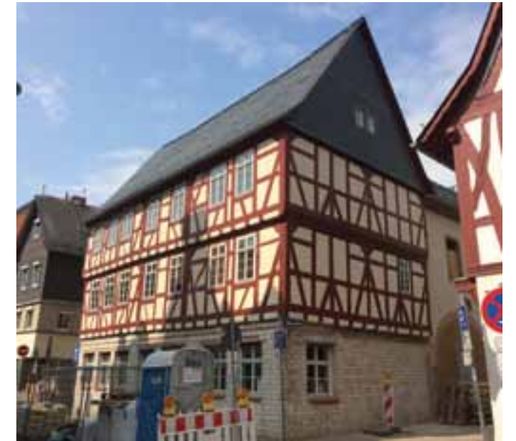
Bolongarostraße 156 während der Sanierung © NH ProjektStadt
