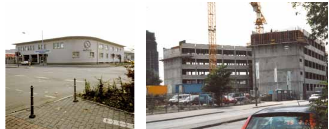
Alter Bestand und Baumaßnahmen Sonnemannstraße/Uhlandstraße/Oskar-von-Miller-Straße
