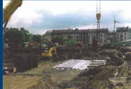
Baustelle Wohnhof Ostendstraße 1998
