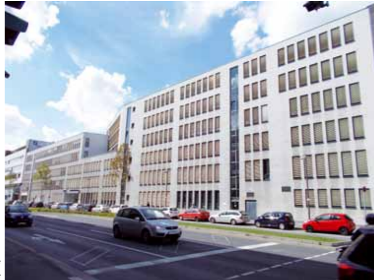
Gebäude der Volkshochschule, Abendgymnasium und Bethmannschule – Ansicht Sonnemannstraße
