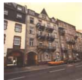
Windeckstraße 19 vor der Modernisierung
