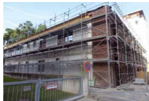
Baustelle Kita Oskar-von-Miller-Straße 2013
