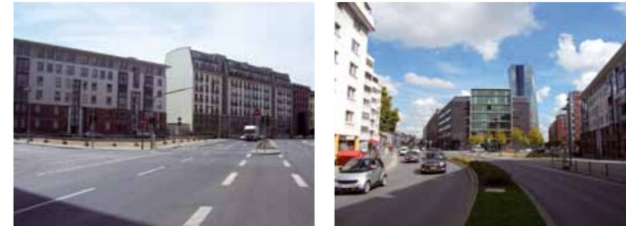
Erschließung Sonnemannstraße – Oskar-von-Miller-Straße – Rückertstraße 2010 und 2014
