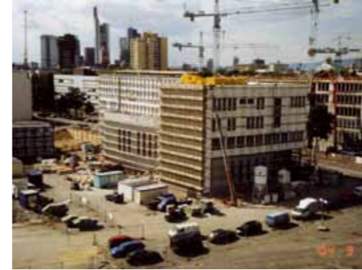
Bauarbeiten Dr. Hoch's Konservatorium 2004
