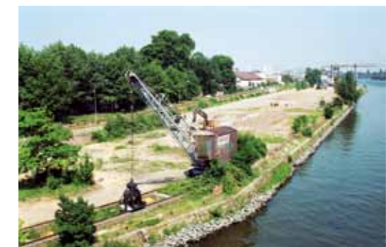
Baumaßnahmen Weseler Werft mit Kran
