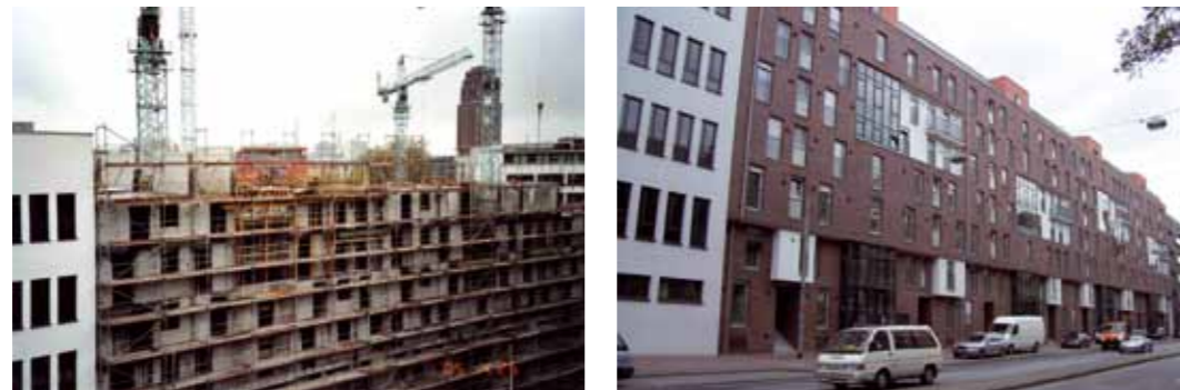
Bauarbeiten Sonnemannstraße 12-16 2005 und 2007
