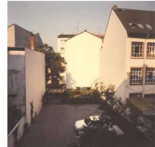
Der Hinterhof Windeckstr. 19 nach der Modernisierung
