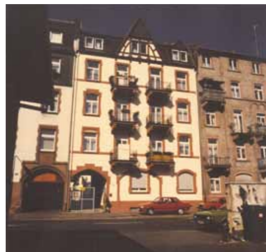
Windeckstraße 19 nach der Modernisierung
