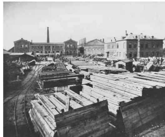
Gelände Philipp Holzmann Unternehmung (Quelle: Institut für Stadtgeschichte Frankfurt am Main; Signatur: S7A1998/141051)
