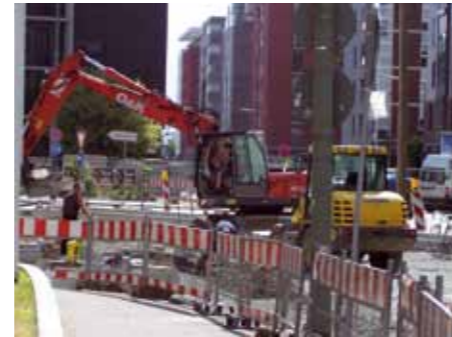
Erschließungsmaßnahmen Sonnemannstraße – Oskar-von-Miller-Straße 2008
