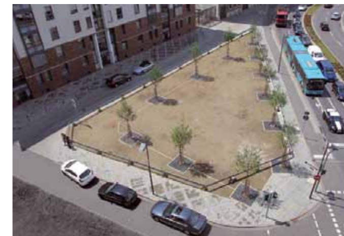
Bestand Martin-Elsässer-Platz – Vogelperspektive vor der Umgestaltung (Quelle: Harald Neu Architekten und Stadtbaearchitekt BDA)
