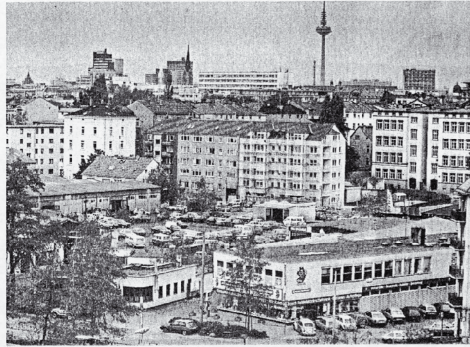
Autos statt Wohnungen: Noch ist das Gelände des Landwirtschaftlichen Vereines durch Gewerbebetriebe blockiert.
