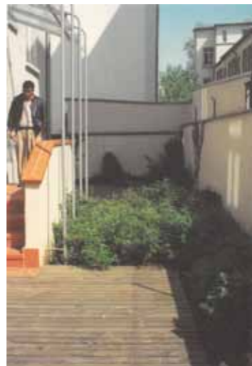
Uhlandstr. 56 nach der Modernisierung
