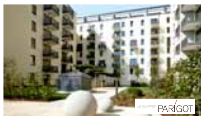
Endenergiebedarf 56 kWh/(m²a), Fernwärme, BJ 2013/2014
