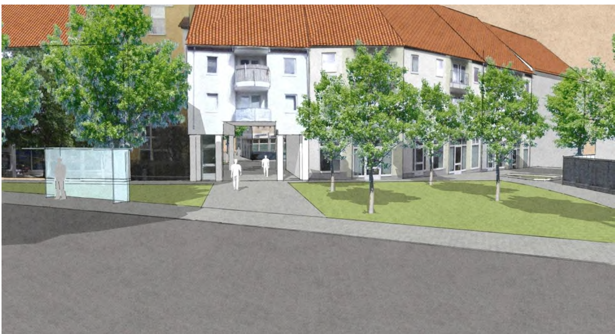
Variante 1: Ansicht von Süden in Richtung Durchgang
