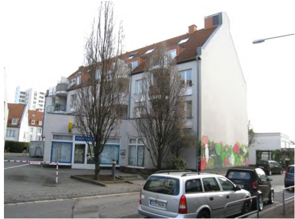
Niederurseler Landstraße 156 mit Durchfahrt Richtung Südosten
