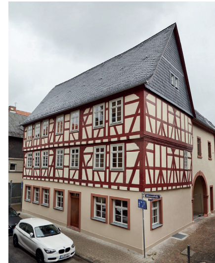
Denkmalgerecht saniert: der Goldene Adler © Michael Meisen
