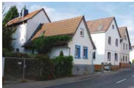
Wohngebäude entlang der Straße Alt-Praunheim
