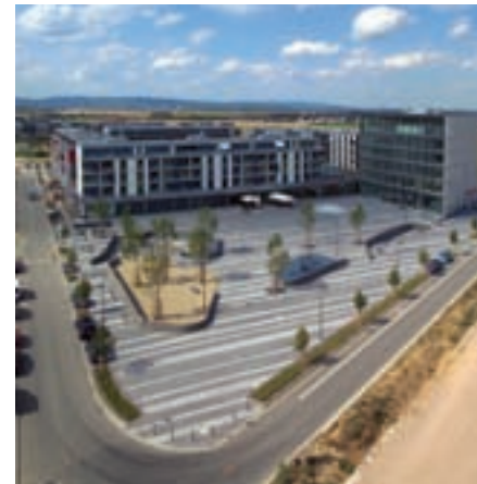
RiedbergZentrum mit Riedbergplatz © Fotodesign Michael Tessmann
