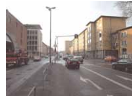
Die Kurt-Schumacher-Straße vor den Baumaßnahmen: Eine umfassende Erneuerung war dringend notwendig
