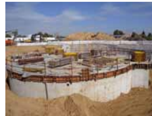
Im Bau: Becken der östlich des neuen Wohnquartiers gelegenen Regenwasserrückhalteanlage
