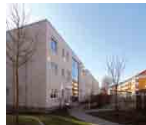
Blick von Osten in den Innenhof
