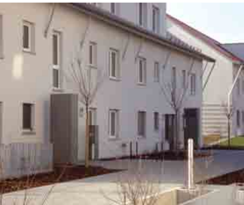
Haus C: Ansicht Eingangsbereich
