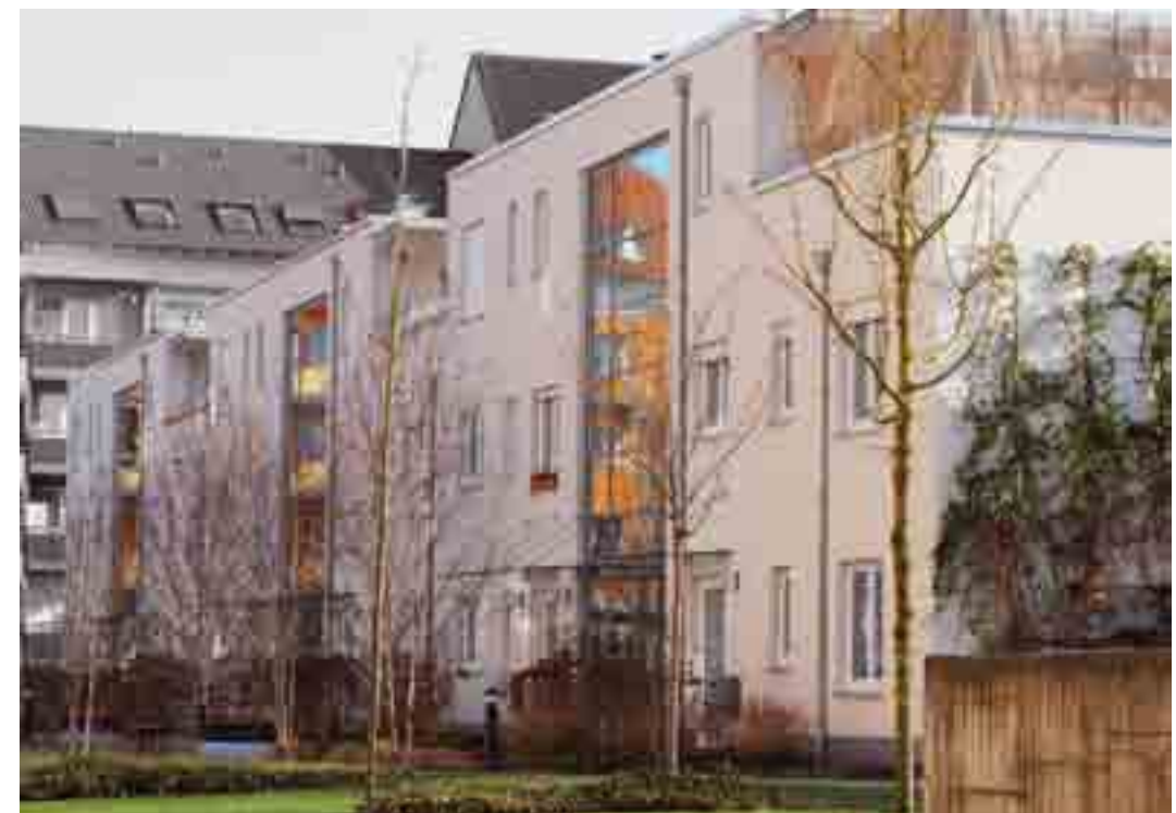
Eingangssituation im Innenhofbereich
