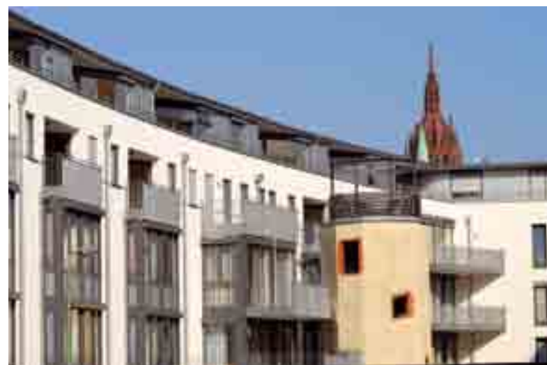
Innenhof mit denkmalgeschütztem Treppenturm
