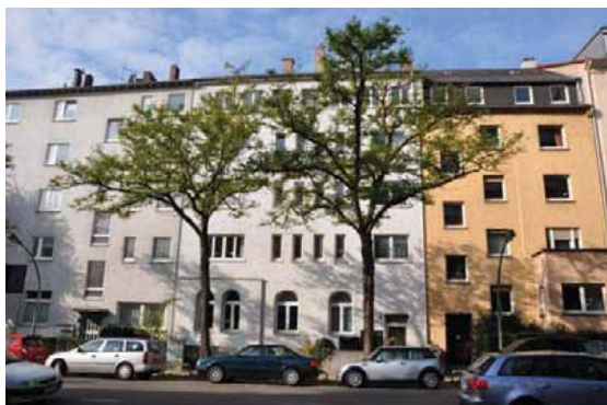
Gräfstraße, Frankfurt am Main
