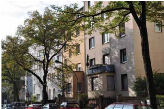
Gräfstraße, Frankfurt am Main
