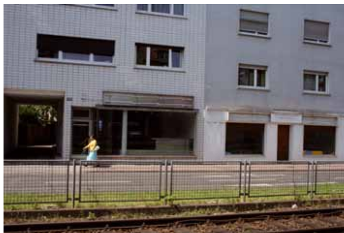
Abbau der Geschäftsleerstände
