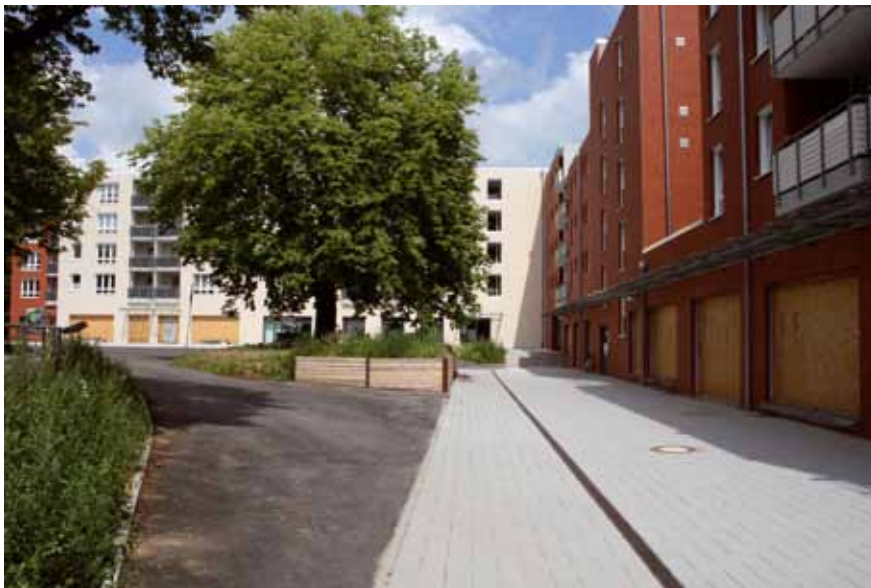
Nahversorgungszentrum Friedberger Warte
