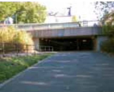
Unterführung Leunastraße – in Richtung Stadt
