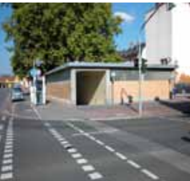
Unterführung Leunastraße – Stadtabgang
