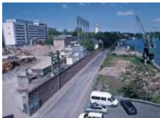
SÜWAG Gelände 2005, Abbruch
