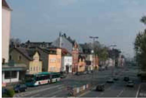
Links: Leunastraße mit Höchst Westend Rechts: Werks- gelände westl. Leunaknoten - bereits freigeräumt
